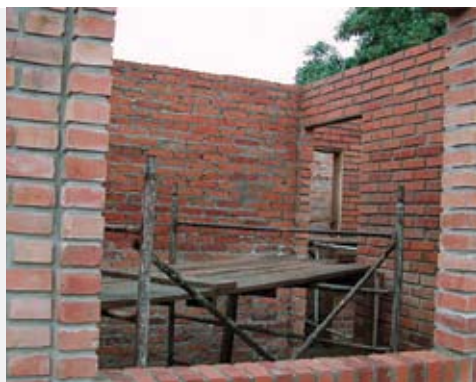
Figura 216 – Elevação das paredes, em 06/06/02
