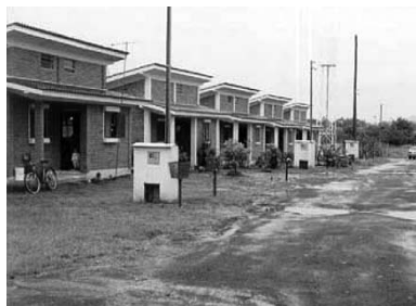
Figura 139 – Vista geral das casas avaliadas na ocasião
