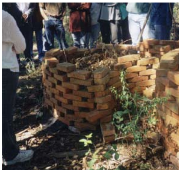
Figura 56 – Composteira construída no Rincão Gaia, com dois compartimentos Foto: Luciana Miron
