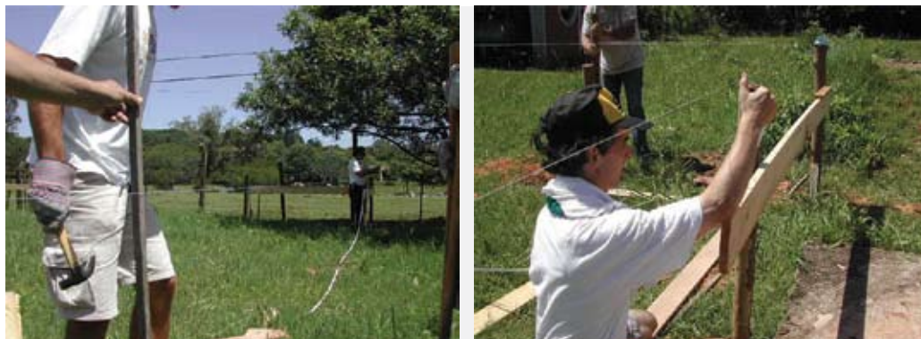
Figura 209 – Marcação da obra, em 28/11/01
