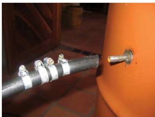
Figura 244 – Fixação da mangueira
