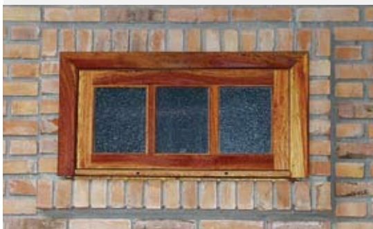
Figura 319 – Janela J2 (cozinha), acima, e janela J5 (banheiro), abaixo, ambas de orientação oeste
