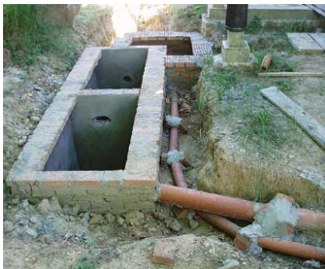
Figura 232 – Sistema modular, com separação de águas negras e cinzas, no protótipo Casa Alvorada. Na extremidade superior da foto à esquerda, a caixa de mistura de águas cinzas (oriundas do banheiro e cozinha), precedida de uma caixa de gordura (para as águas da cozinha)
