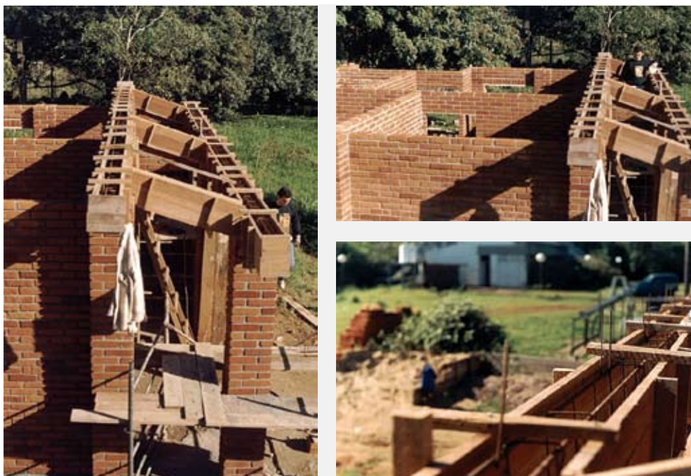
Figura 218 – Vigas de coroamento (telhado sul, inferior), em 14/06/02
