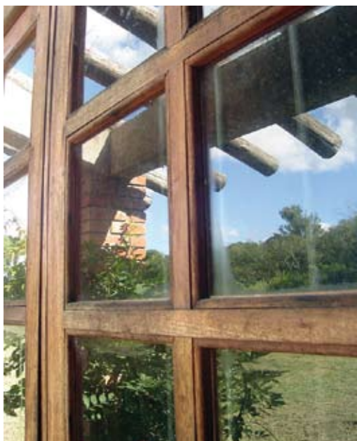
Figura 323 - Janela do dormitório norte
