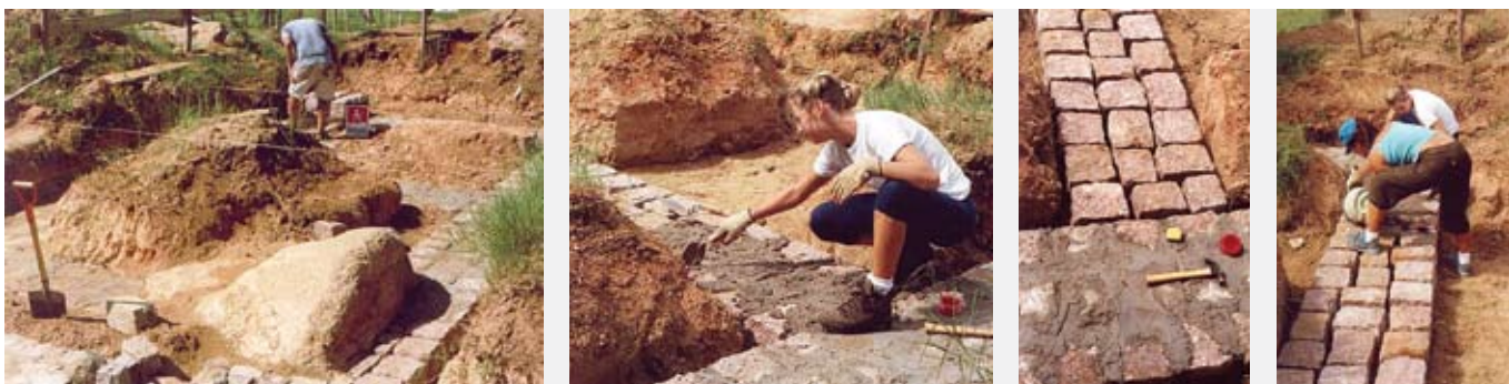
Figura 213 – Construção dos alicerces sobre o berço, em 02/03/02
