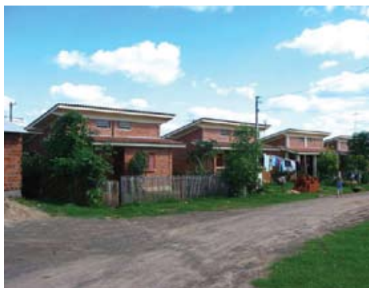
Vista do conjunto de casas construídas segundo o modelo desenvolvido para o CETHS
