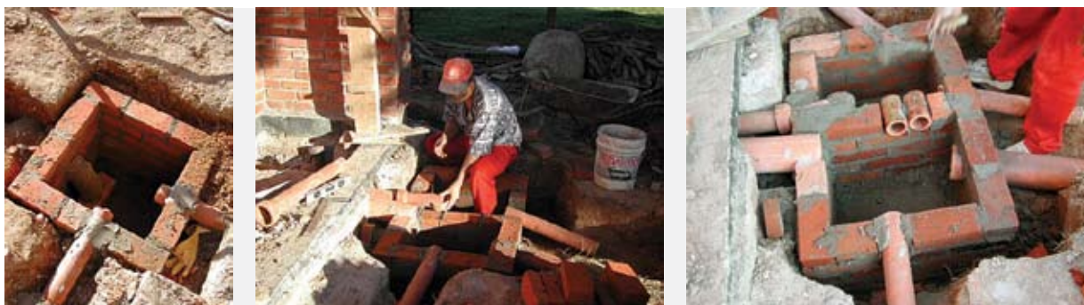
Figura 219 – Execução das caixas de gordura e filtros, em 18/07/02
