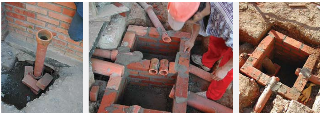
Figura 229 – Sifão (à esquerda) e decantadores do sistema de tratamento
