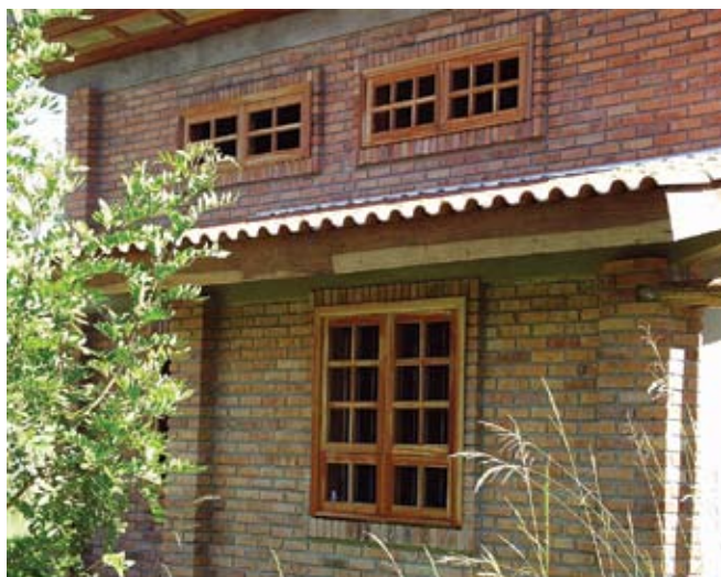
Figura 315 – Vista noroeste do protótipo de habitação mais sustentável
