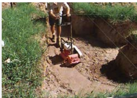
Figura 212 – Preparação do berço para as fundações, em 04/02/02
