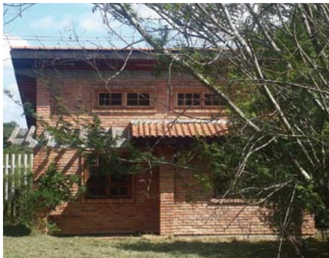
Figura 313 – Vista norte do protótipo Alvorada
