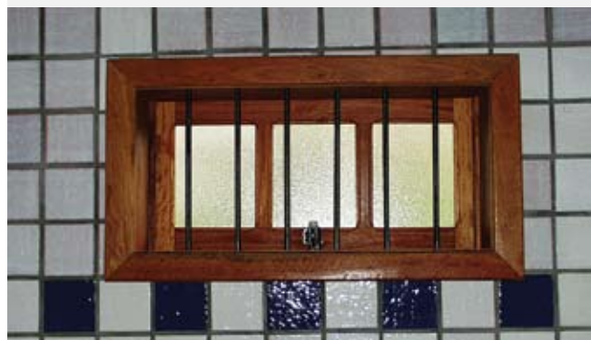
Figura 320 – Vista desde o interior, das janelas J3 (dormitório norte), acima, e J5 (banheiro)
