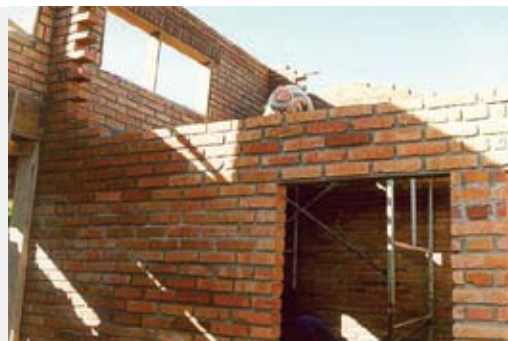
Figura 220 – Fachada norte (parte superior), com janelas superiores, em 18/07/02
