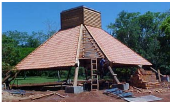
Figura 8 – A Choupana, no Refúgio Biológico Bela Vista (projetada para enfatizar a estratégia e as possibilidades de reúso de resíduos de construção) Foto do autor.
