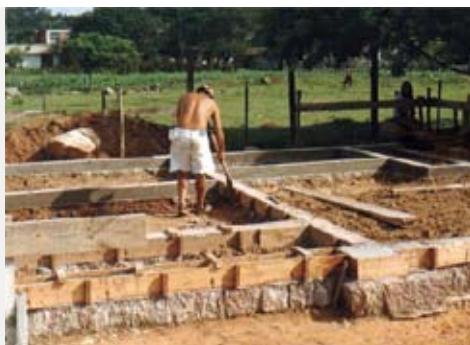
Figura 214 – Execução das formas para as vigas de fundação, em 20/03/02
