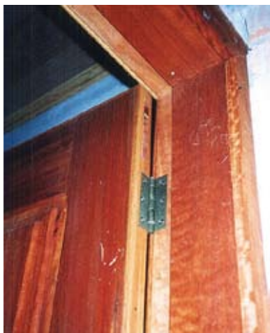
Figura 322 – Detalhe do sistema de emenda através de espiga na porta P1
