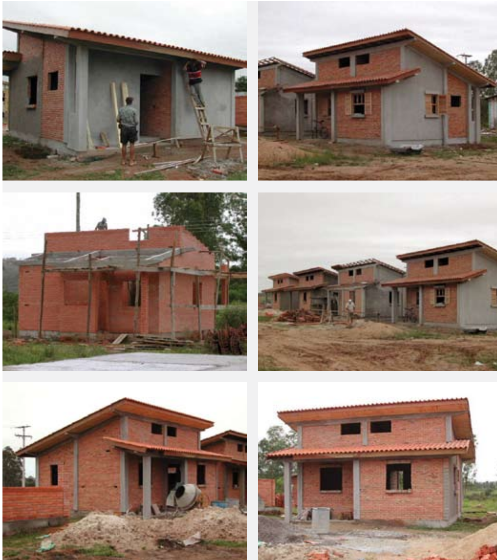
Figura 133 – Imagens da implantação (Casa Verena, linha central, à esquerda), em 29/11/01
