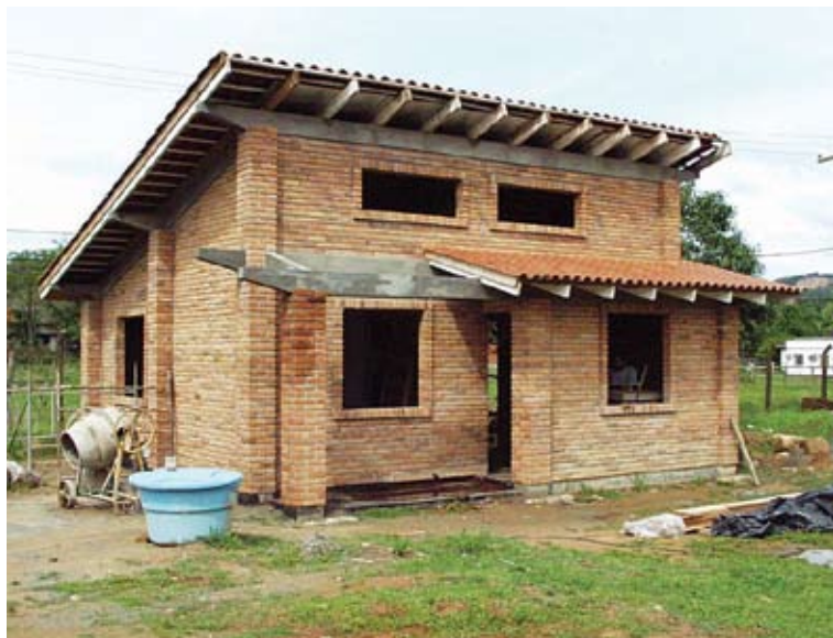
Figura 221 – Edificação pela primeira vez coberta, em 31/10/02
