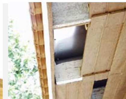
Figura 250 – Detalhes da ventilação de telhado (esquerda: placa metálica; centro: beiral superior; esquerda: beiral inferior)
