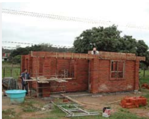
Figura 217 – Execução das vigas de coroamento das paredes, em 13/06/02
