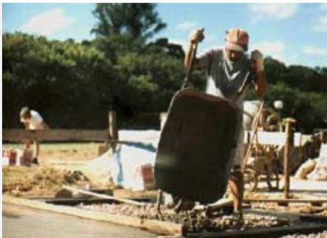
Figura 215 – Construção do piso, em 04/05/02
