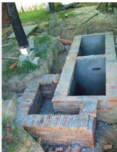
Figura 232 – Sistema modular, com separação de águas negras e cinzas, no protótipo Casa Alvorada. Na extremidade superior da foto à esquerda, a caixa de mistura de águas cinzas (oriundas do banheiro e cozinha), precedida de uma caixa de gordura (para as águas da cozinha)
