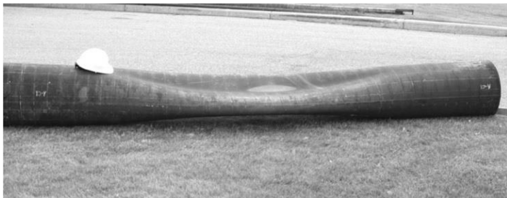
Figura 1. Colapso por flambagem local de uma tubulação sob pressão externa.
