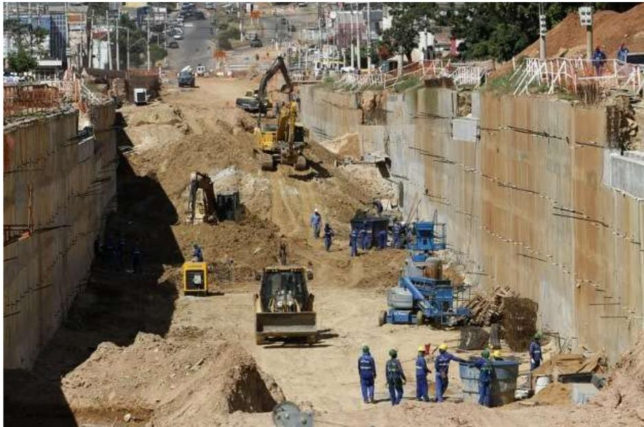
Figura 3 - Canteiro tipo linear (fonte: escolaengenharia.com.br)
