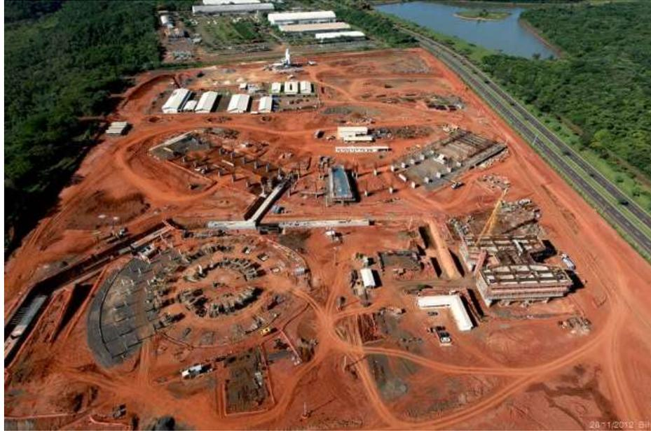
Figura 2 - Canteiro tipo amplo (Fonte: escolaengenharia.com.br)
