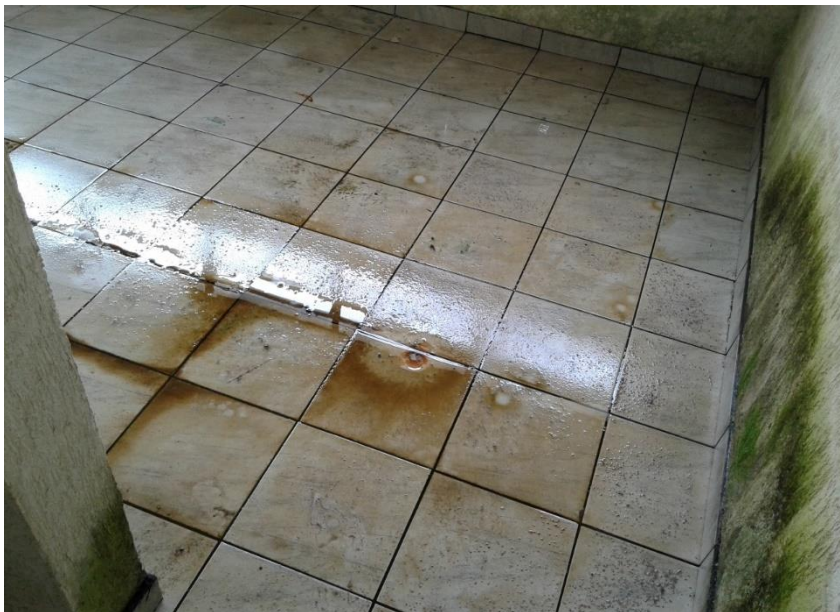
Figura 15: Piso e parede do vestiário da Praça da Juventude com mofos e concentração de água devido às infiltrações.
