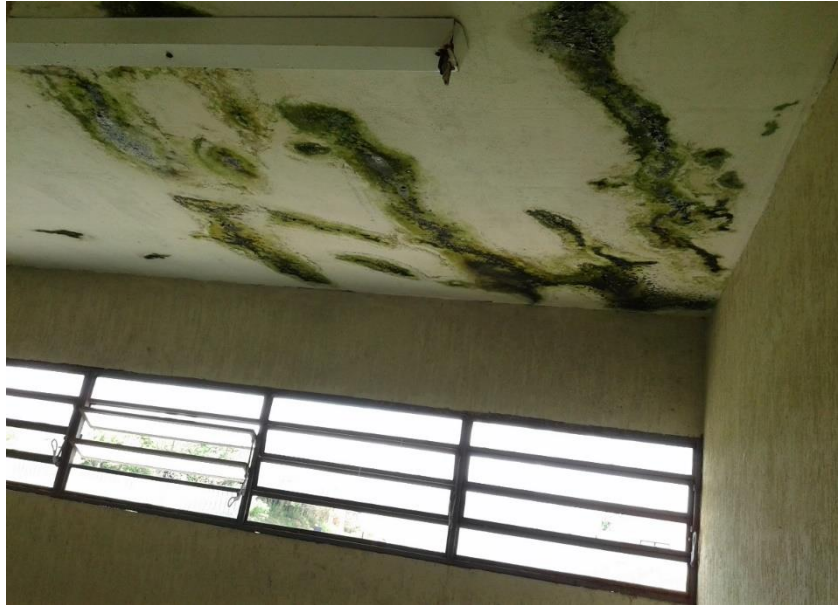
Figura 14: Teto do vestiário da Praça da Juventude com mofos e infiltrações.
