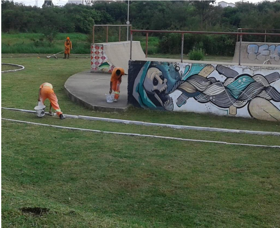
Figura 154: Funcionários da MecaniCapina fazendo a pintura dos meios-fios da Praça da Juventude.
