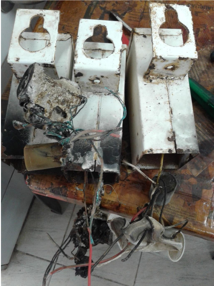
Figura 208: Fios e refletores da quadra poliesportiva danificados pelo curto circuito em 2017 resultando na ausência de iluminação na quadra que perdurou até maio de 2019.
