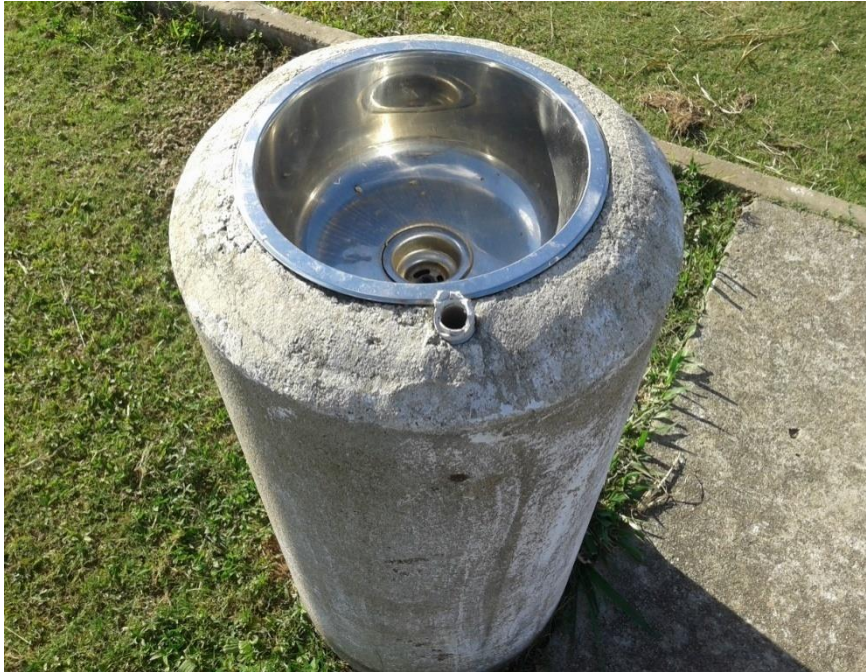
Figura 24: Bebedouro quebrado e desativado.
