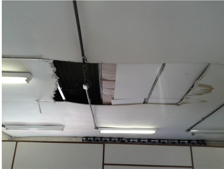
Figura 194: Forro da cozinha do prédio administrativo da Praça da Juventude que permanece quebrado e se mantém na iminência de despencar.
