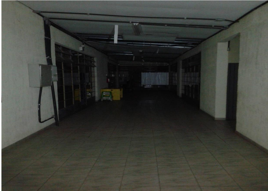
Figura 149: Imagem da PJ registrada de janeiro a 07 de maio de 2019, período em que o espaço público permaneceu totalmente sem iluminação e energia elétrica [corredor do prédio administrativo].
