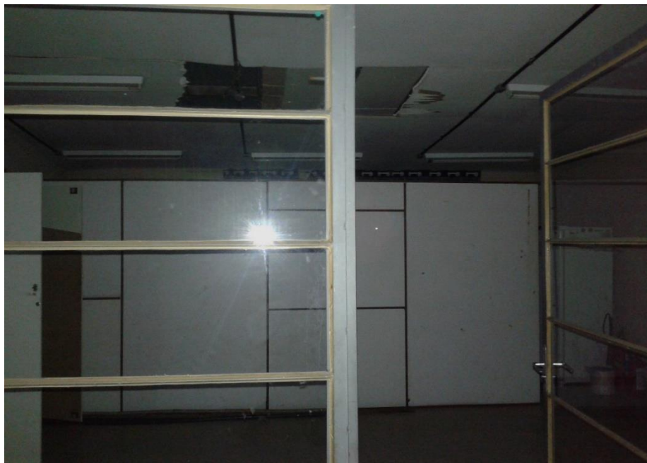
Figura 150: Imagem da PJ registrada de janeiro a 07 de maio de 2019, período em que o espaço público permaneceu totalmente sem iluminação e energia elétrica [sala utilizada para a alimentação dos guardas e da gestora/ao fundo está localizada a cozinha].
