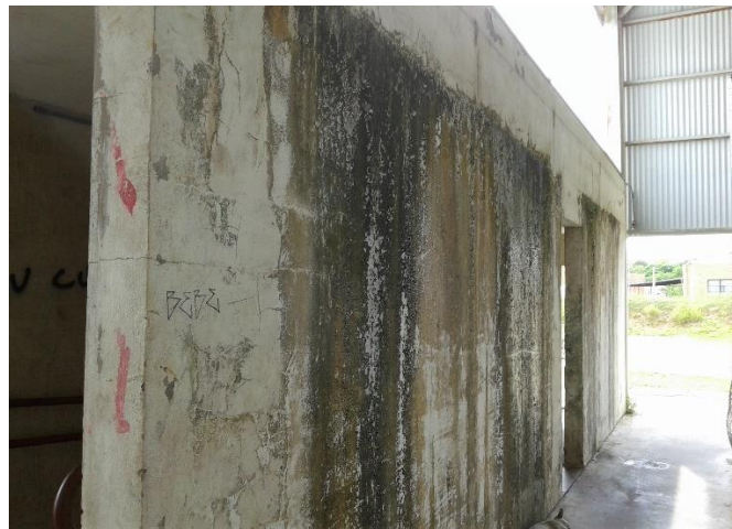
Figura 197: Mofos decorrentes de infiltrações que permanecem em uma das paredes do vestiário localizado atrás da quadra poliesportiva.
