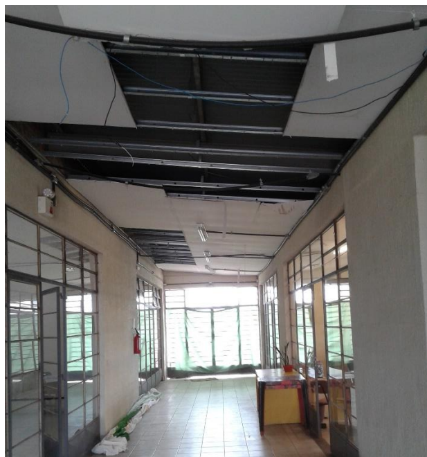
Figura 195: Forro do corredor do prédio administrativo da Praça da Juventude que permanece quebrado e se mantém na iminência de despencar.
