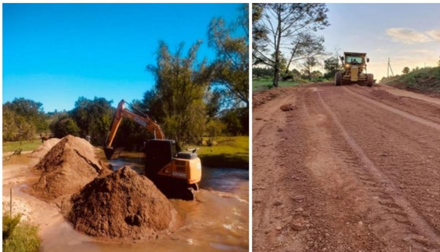
**Figura 5- Desassoreamento no município de Camaquã/RS, com uso benéfico do material.**
