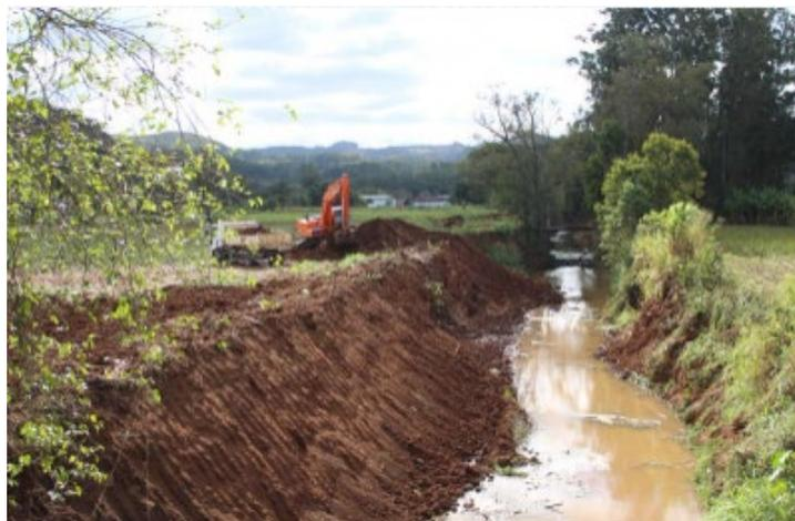
**Figura 6- Desassoreamento de trecho de arroio, no município de Maratá/RS.**
