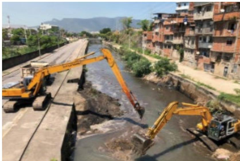
**Figura 2- Escavadeiras demonstrando a versatilidade de operação dentro e fora do canal.**
