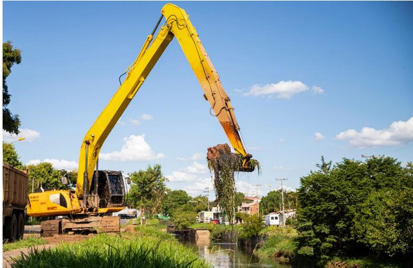
**Figura 1- Dragagem escavadeira de braço longo operando no Arroio João Corrêa – São Leopoldo / RS**
