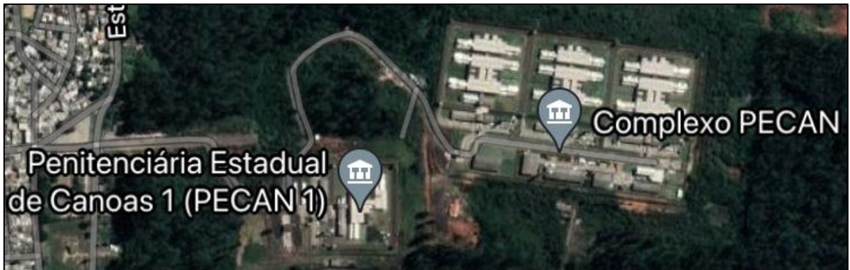
Figura 2 - Complexo Prisional de Canoas – vista aérea vertical
