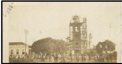
Figura 3. Construção da torre da Igreja em 1930
