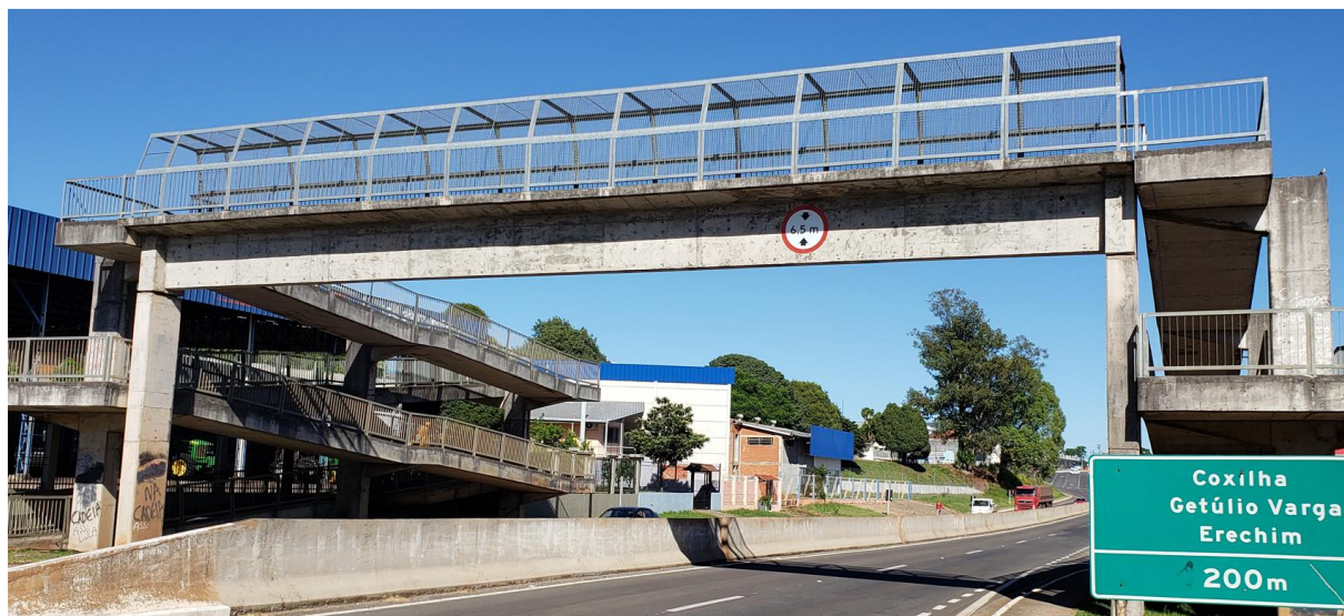
Figura 5.26 – Foto da Passarela P01
