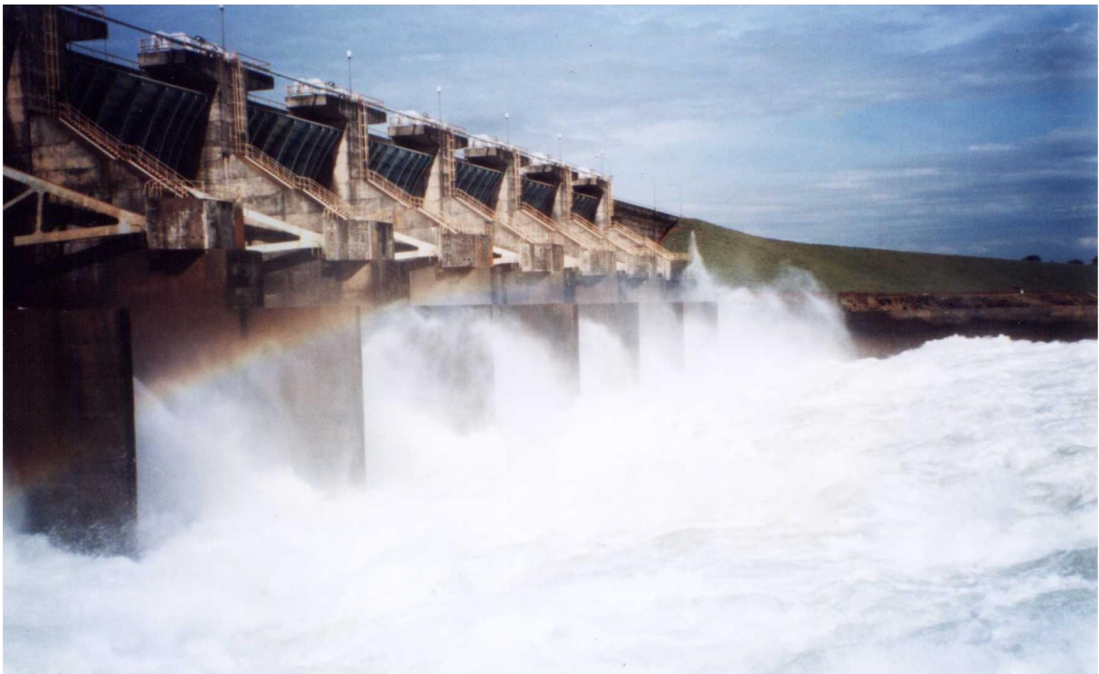
Figura 1 – Ressalto hidráulico formado na UHE de Porto Colômbia. Fonte: Marques, Almeida e Endres (1999)
