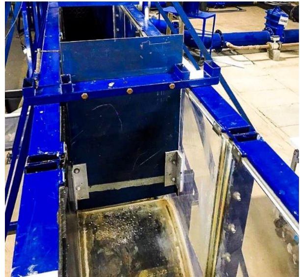
Figura 49 – Comporta plana instalada sobre a ogiva
