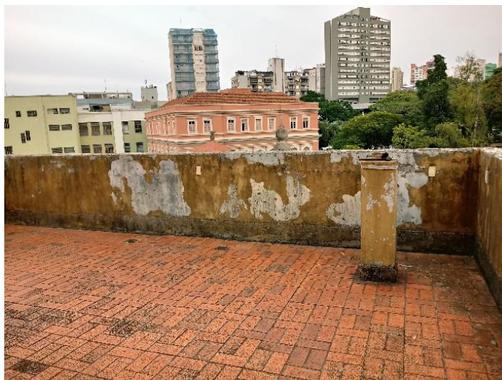
Figura 40 – Piso em tijoleira de barro
