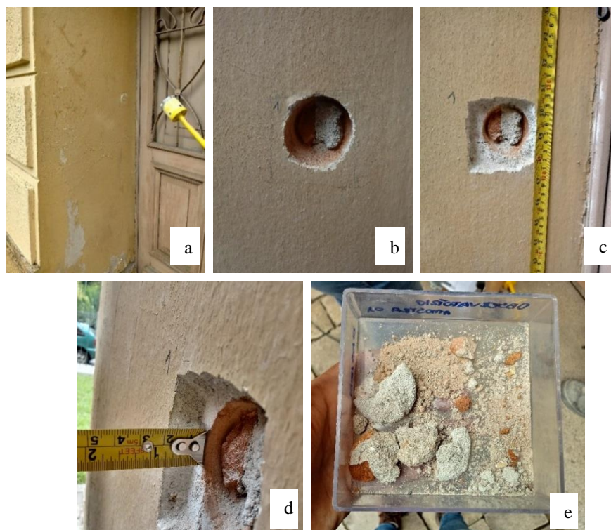
Figura 54 – Fotos da extração da amostra 1: (a) início da perfuração da amostra 1; (b) extração feita com serra copo, as laterais foram retiradas para complementar a amostra; (c) marcação da altura; (d) marcação da espessura; (e) amostra 1.
