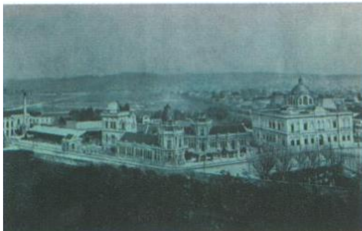
Figura 22- Vista geral a partir da Santa Casa
