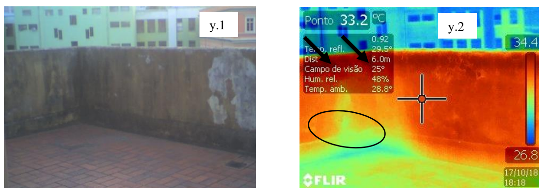
Figura 103 – y.1 e y.2.: Fachada Oeste (platibanda – parte interna esquerda)
