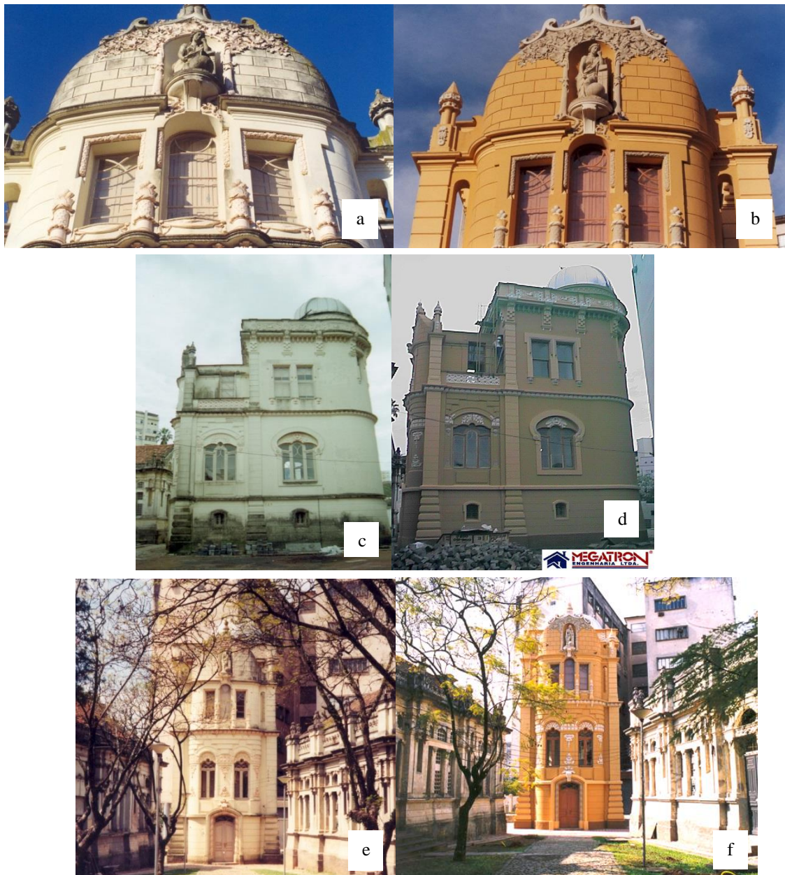
Figura 30 – Fotos do OA, antes e depois da restauração: (a) e (b). Coroamento (antes e depois); (c) e (d). Fachada Sul (antes e depois); (e) e (f). Fachada Oeste (antes e depois).
