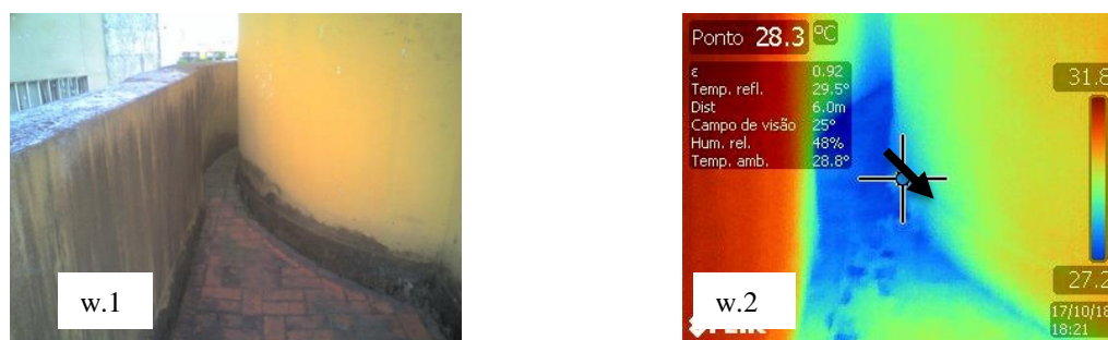
Figura 101 – w.1 e w.2.: Fachada Leste (cobertura – parte inferior)
