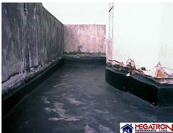
Figura 42 – Impermeabilização na cobertura
