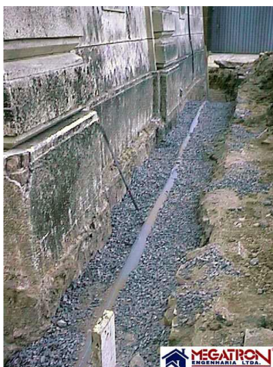
Figura 41 – Obra de drenagem
