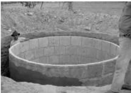
A cisterna de placas em construção e terminada
