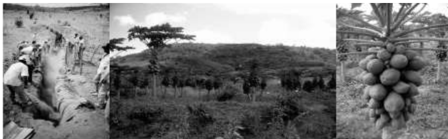
Barragem subterrânea em construção e terminada, produzindo.
