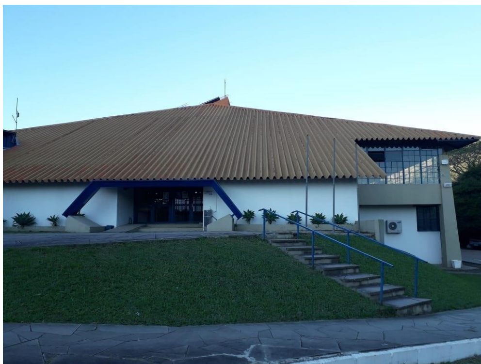
Figura 3 – Lado externo do ginásio, visto de frente.
