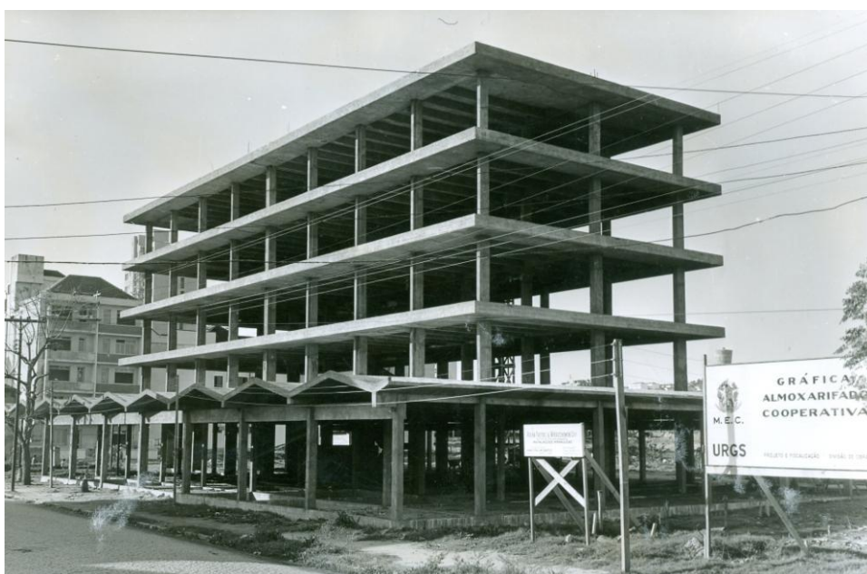
Figura 5 - Foto da construção do prédio que hoje abriga a FABICO Fonte: Imagem Museu da UFRGS
