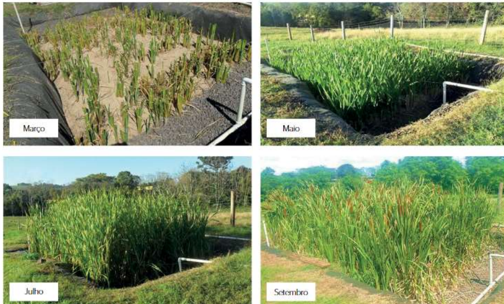
Figura 23 – Desenvolvimento da macrófita Typha domingensis Pers. em wetland construído de fluxo horizontal ao longo do período de estudo
