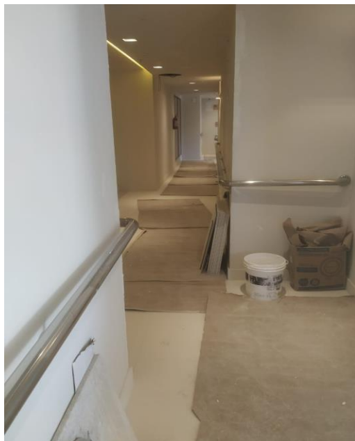
Figura 14- Detalhe dos corrimãos da circulação tipo
