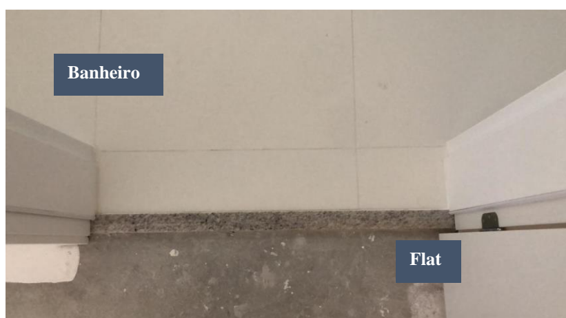
Figura 27 - Bit/Soleira instalada na porta do banheiro
