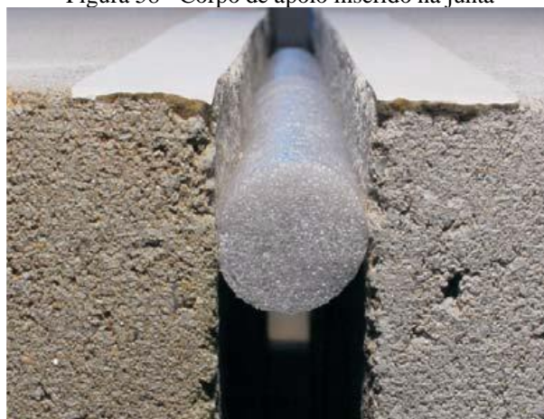
Figura 58 - Corpo de apoio inserido na junta
