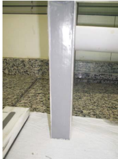
Figura 46 - Verificação do escoamento do selante
