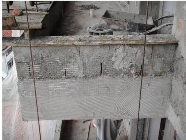
Figura 20 - Tela na interface da alvenaria com topo de viga
