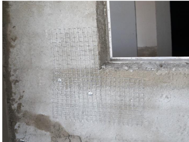
Figura 22 - Telas nos cantos das aberturas
