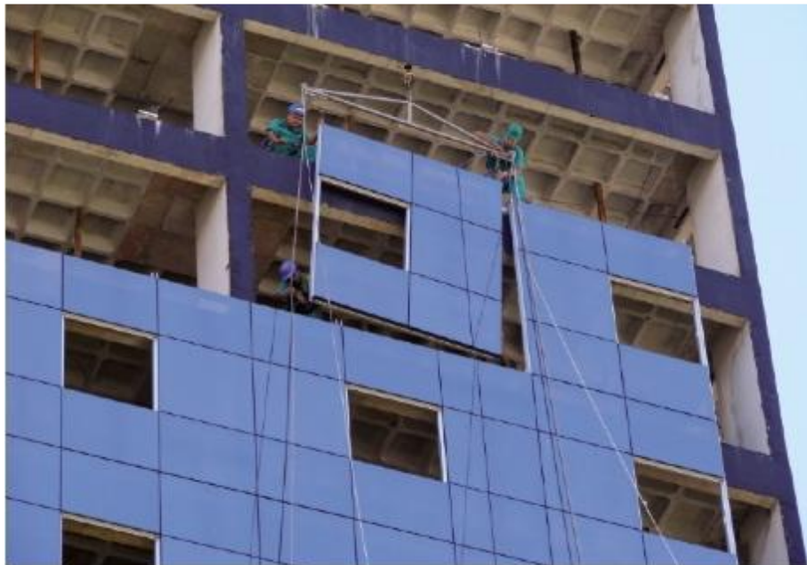
Figura 8 - Içamento de módulo do sistema unitized de fachada de pele de vidro
