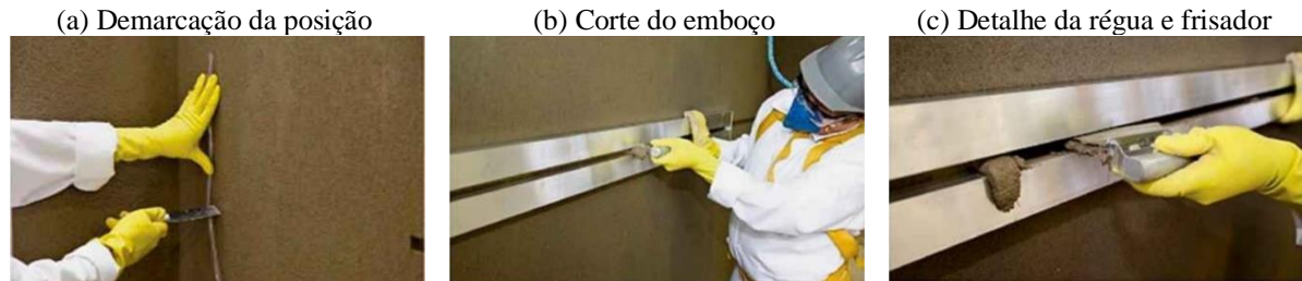
Figura 37 - Abertura de junta de movimentação com corte do emboço
