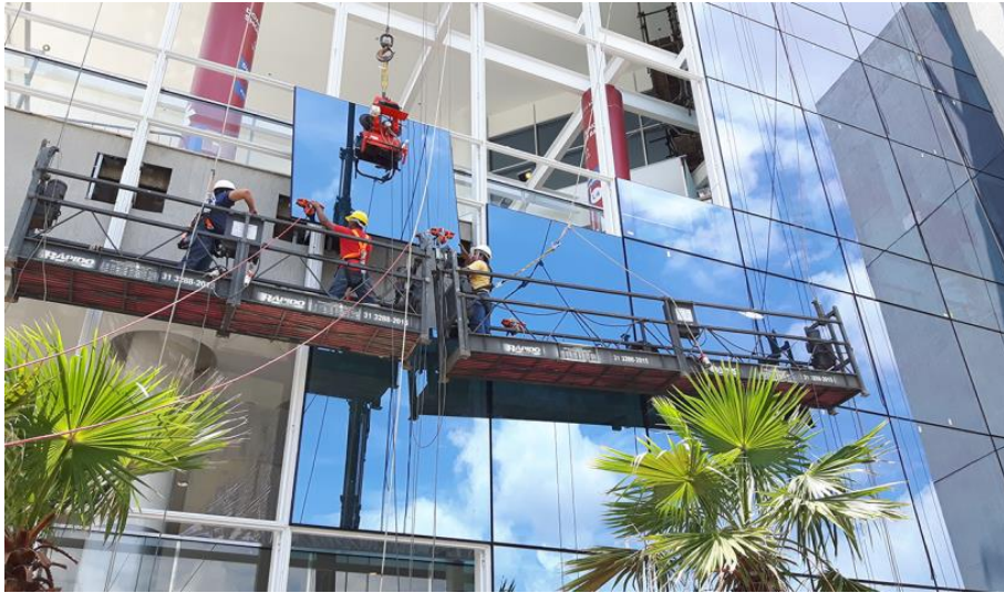
Figura 7 - Montagem de fachada de pele de vidro por sistema stick
