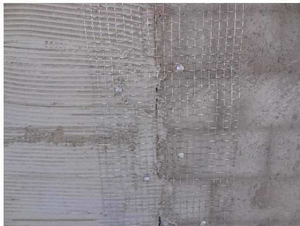
Figura 21 - Tela na interface da alvenaria com pilar
