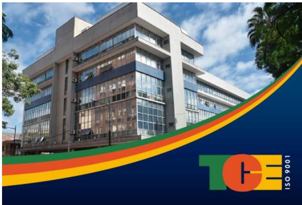
Figura 7 - Prédio sede do Tribunal de Contas do Estado do Rio Grande do Sul.
