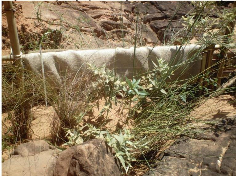
Os biorretentores foram cobertos por sedimentos carregados de montante, sendo estes posteriormente colonizados por espécies ruderais nativas, após a fixação do sedimento na base das estruturas.
