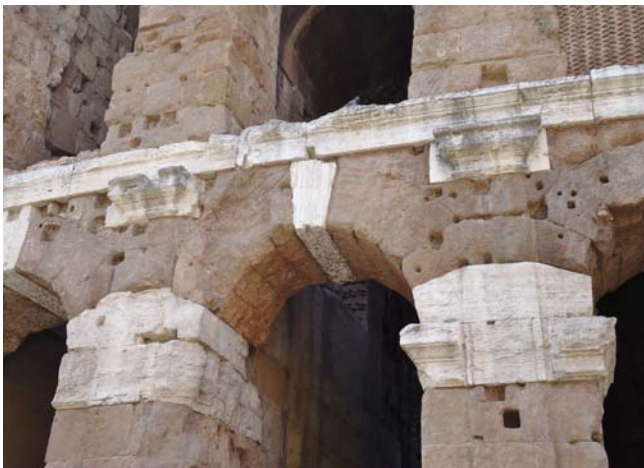
Figura 3: Detalhe construtivo dos encaixes de diferentes pedras na ruína. Fonte: Foto do autor.
