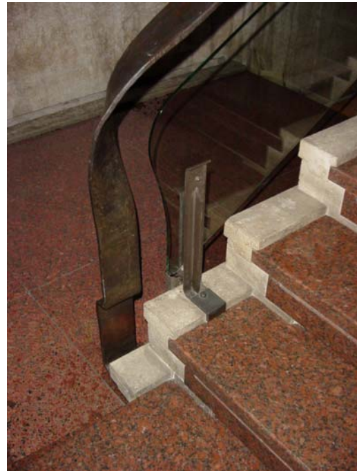
Figura 4: A escada de Quaroni, com o degrau de granito encaixado no travertino e o corrimão de definição artesanal.
