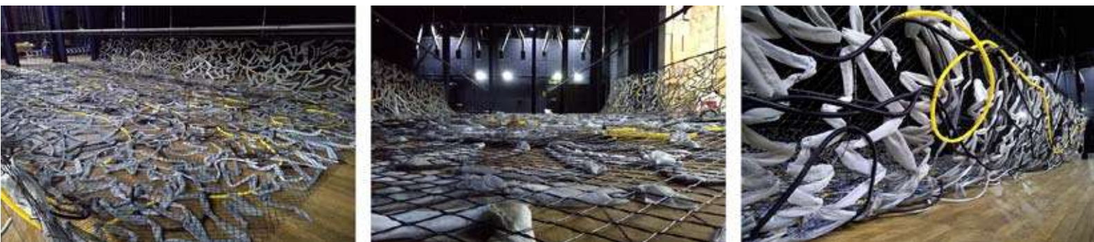
Figura 6: O aspecto do cenário durante a montagem do espetáculo. É possível visualizar a estrutura de tela plástica hexagonal, os tecidos de cor cinza, os eletrodutos e as amarrações nas varas de cenografia. Fonte: Stefanello Studio.
