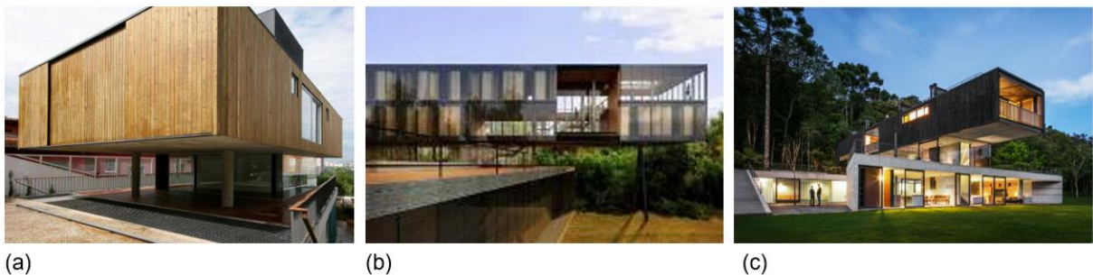
Figura 18: Base-pilotis-volume suspenso: (A) Casa Pinheiros (2007); (B) Complexo de Campos do Jordão (2009); (C) Casa Mantiqueira (2012). (1)
