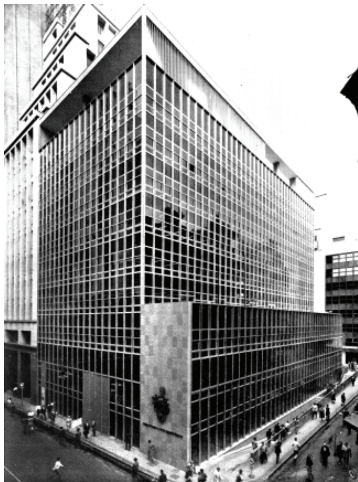
Figura 3: Bank of London & South America (1959), em São Paulo, de Mindlin e Palanti Fonte: Revista Acrópole , n. 300, p. 357.
