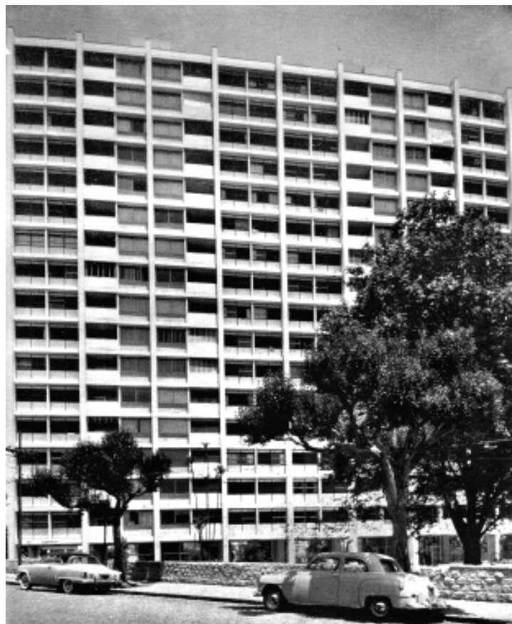
Figura 2: Edifício João Ramalho (1953), em São Paulo, com solução de fachada análoga ao Promontory de Mies. Prêmio Internacional da Categoria Habitação Coletiva, na IV Bienal de SP Fonte: Revista Acrópole , n. 282, p. 55.
