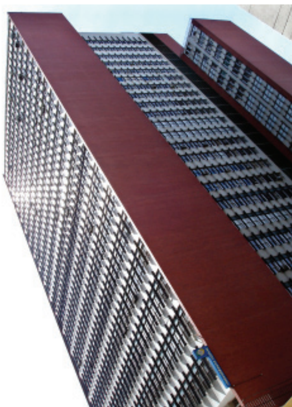
Figura 8: Edifício IPASE, Porto Alegre, com o efeito gráfico dos perfis-brises sobre as janelas rasgadas Fonte: Autor
