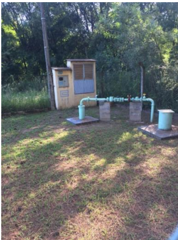
Figura 16: Poço padrão CORSAN segundo NBR 12444 da ABNT (2006).
