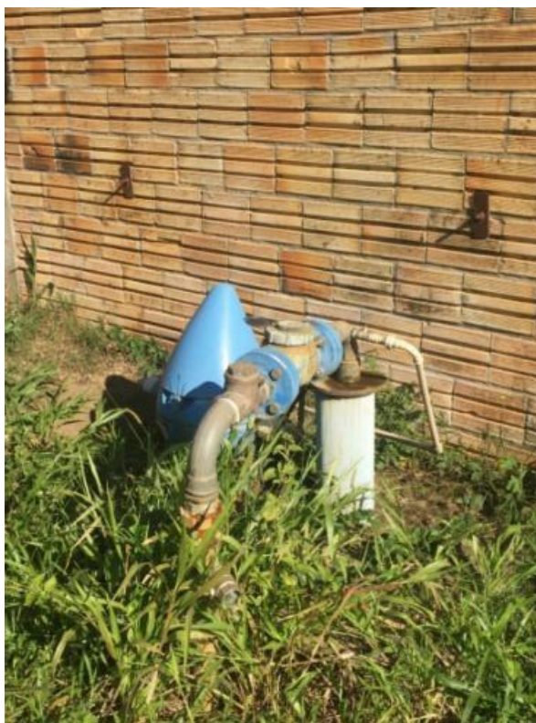
Figura 17: Poço construído de forma irregular.
