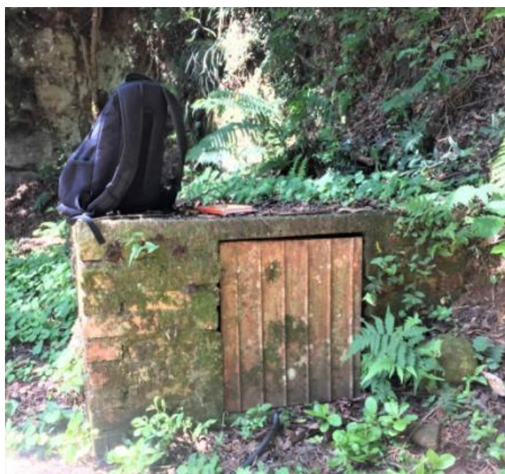
Figura 19: Caixa de armazenamento junto ao pé da encosta.
