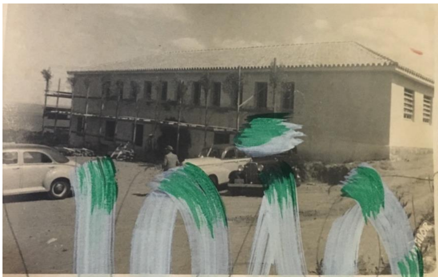
Figura 39 Construção do prédio da Instituição, década de 1940. (Foto: acervo da autora.)
