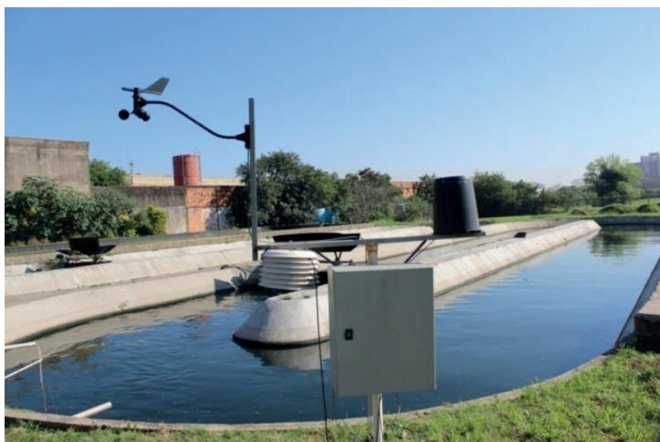
Figura 1. Lagoas de Alta Taxa piloto em pleno funcionamento na ETE experimental.
