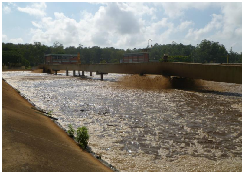
Figura 2. Tanque de aeração. Lodo ativado de aeração prolongada – Superintendência de Tratamento de Efluentes Líquidos (SITEL).
