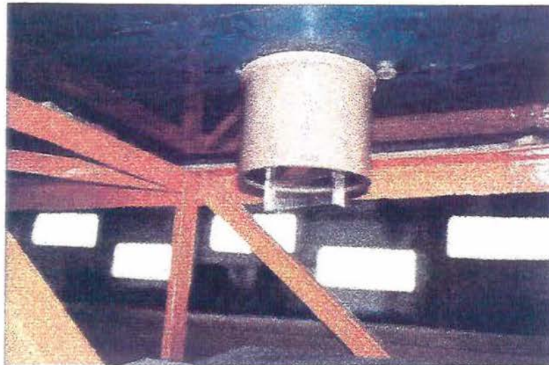
Figura 4.8 Vista sob o canal do local de colocação do cilindro contendo agregados de solo.
