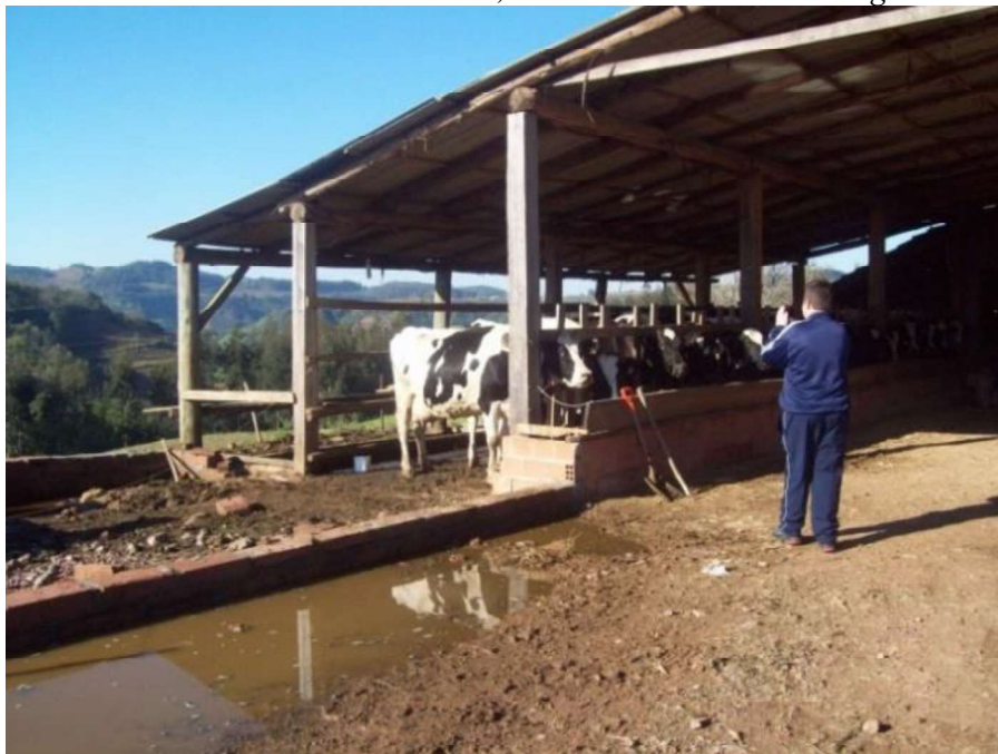
Figura 6 - Problemas na localidade rural, estábulo com acúmulo de água e umidade
