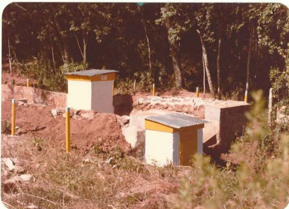
FOTO Nº 4 - ESTRUTURA DE COLETA DE INFORMAÇÕES HIDROMÉTRICAS E SEDIMENTOMÉTRICAS DA SUB-BACIA B1
