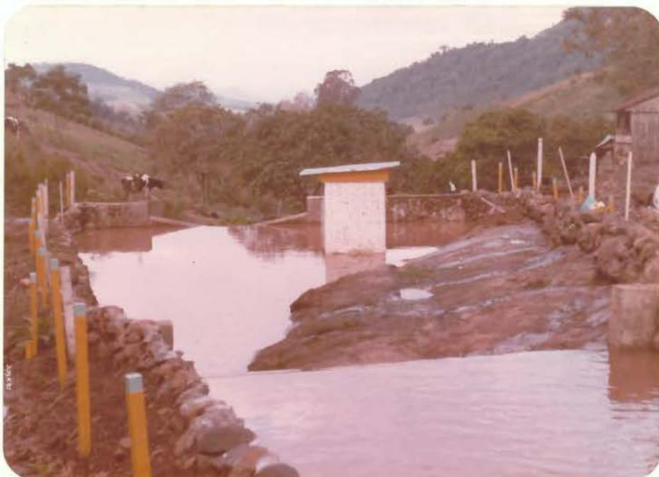
FOTO Nº 2 - ESTRUTURA DE COLETA DE INFORMAÇÕES HIDROMÉTRICAS E SEDIMENTOMÉTRICAS DA SUB-BACIA A1
