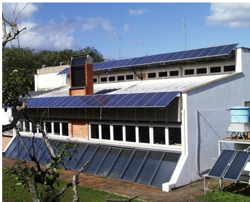
Figura 19 – Prédio principal do Labsol - UFRGS.
