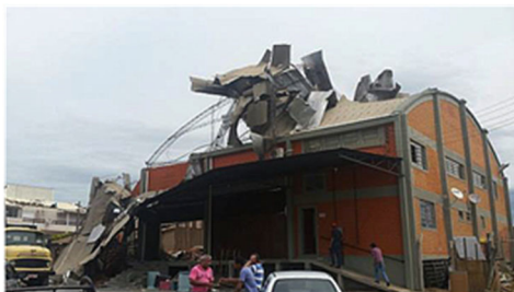
Figura 6 – Destelamento e queda de galpões em Tubarão – SC (a, b, c)
