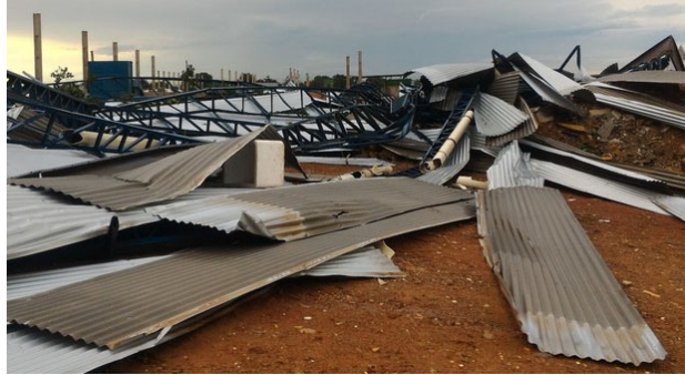
Figura 7 – Galpão de reciclagem de Aparecida de Goiânia - GO
