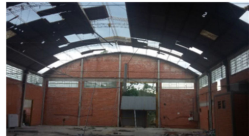
Figura 6 – Destelamento e queda de galpões em Tubarão – SC (a, b, c)
