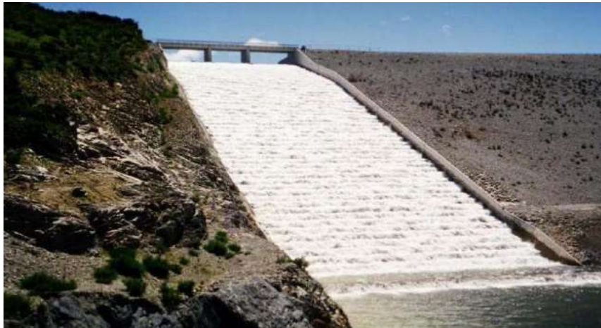
Figura 5 – Vertedouro em degraus em funcionamento submetido a escoamento deslizante sobre turbilhões – Barragem Opuha, Nova Zelândia.
