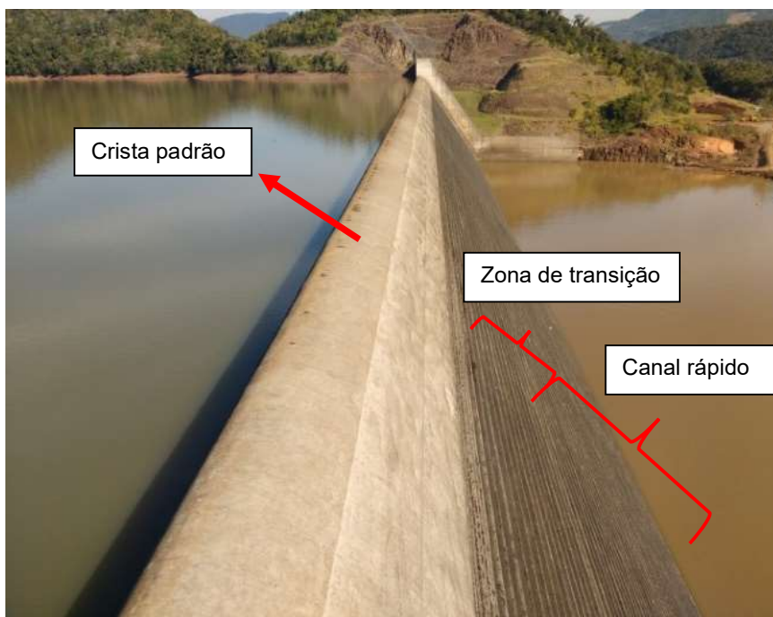
Figura 3 – Vertedouro em degraus da Barragem de Dona Francisca, no Rio Grande do Sul.
