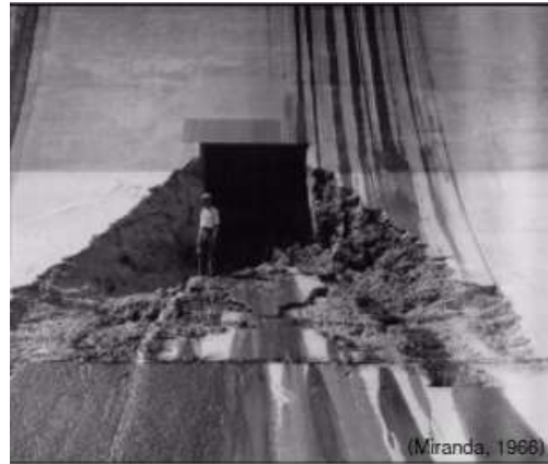
Figura 2 – Danos por cavitação no vertedouro de concreto na Barragem Kinzua Pennsylvania.
