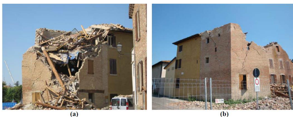
Figura 1.1 - Colapso parcial de edificação de alvenaria em San Felice sul Panaro: (a) Vista do canto colapsado e (b) vista oposta ao canto colapsado (Adaptada de PARISI et al., 2012).
