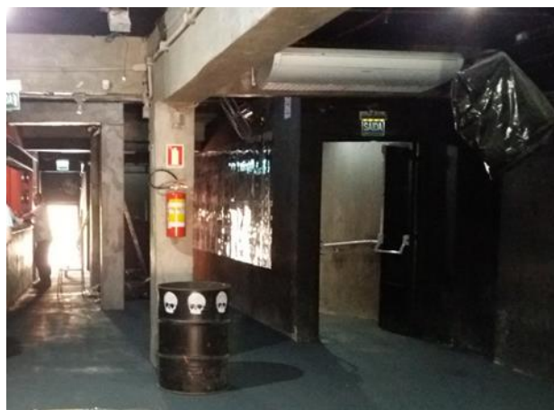
Figura 15 – Foto do corredor enclausurado executado
