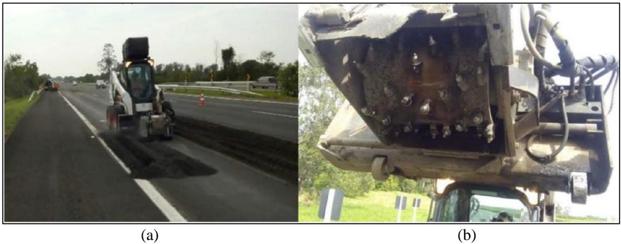
Figura 3.3 - Equipamento realizando serviço de fresagem(a) e detalhe do tambor de fresagem (b). (LUZZI, 2019)
