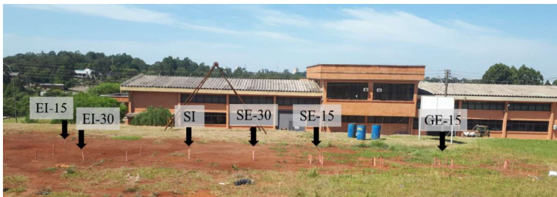
Figura 3.5: Localização para execução das fundações e provas de carga
