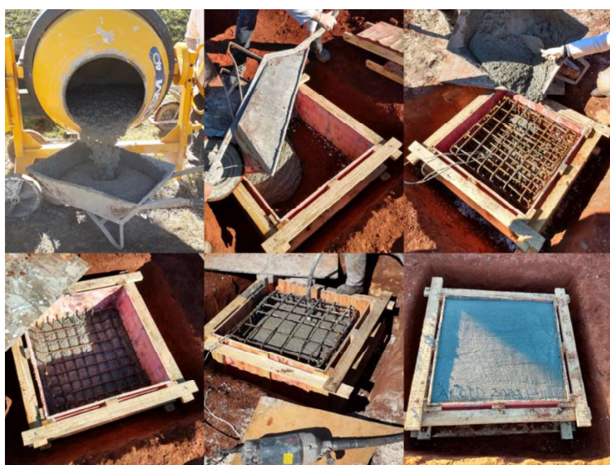
Figura 3.15: Concretagem dos blocos
