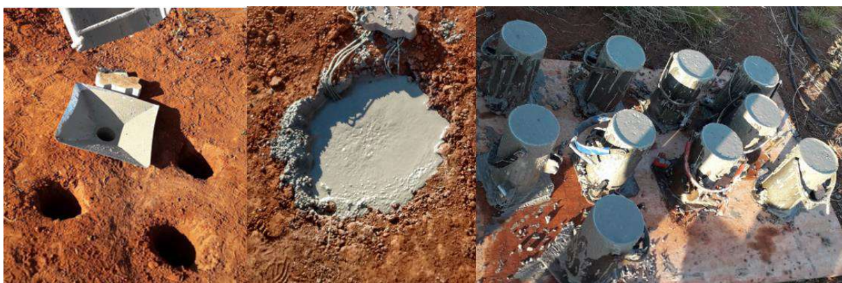
Figura 3.11: Concretagem das estacas
