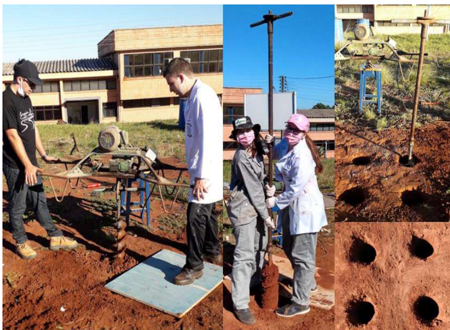
Figura 3.10: Escavação das estacas de 15 cm
