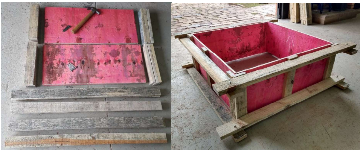
Figura 3.8: Materiais de composição e fôrma montada
