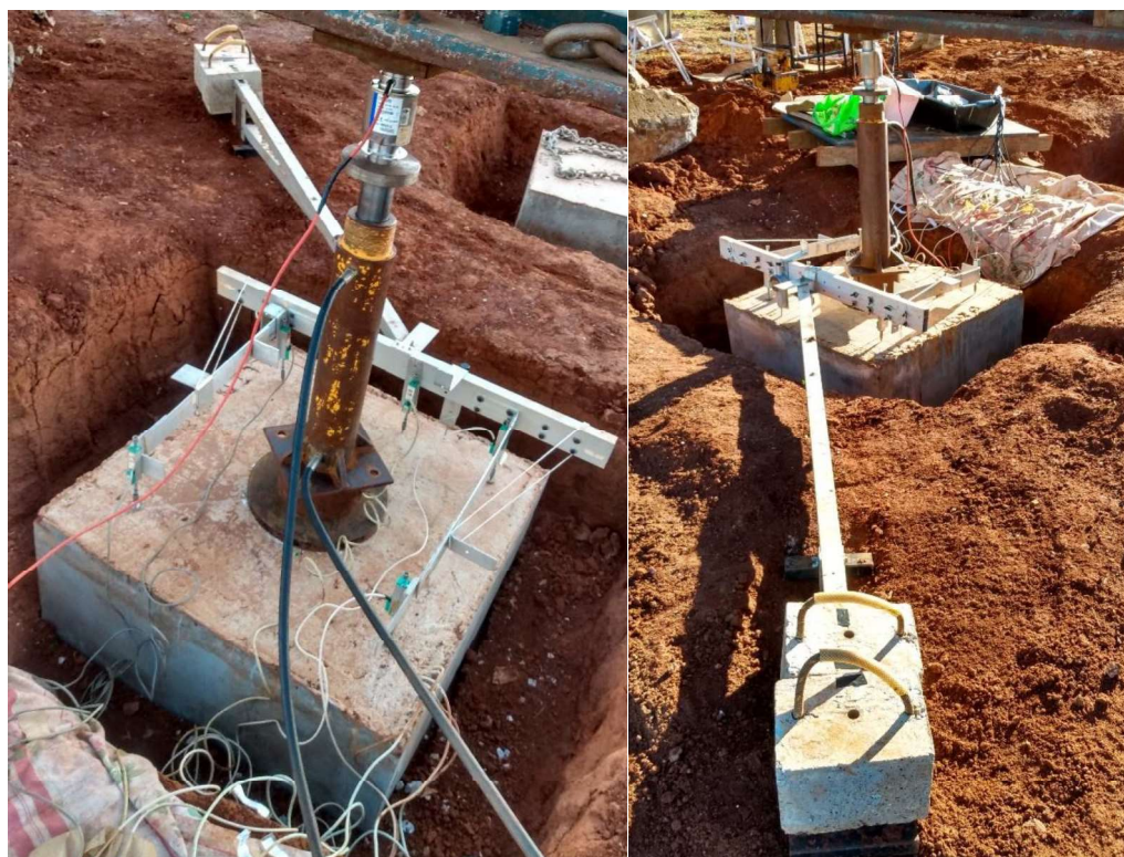
Figura 3.26: Montagem completa dos ensaios
