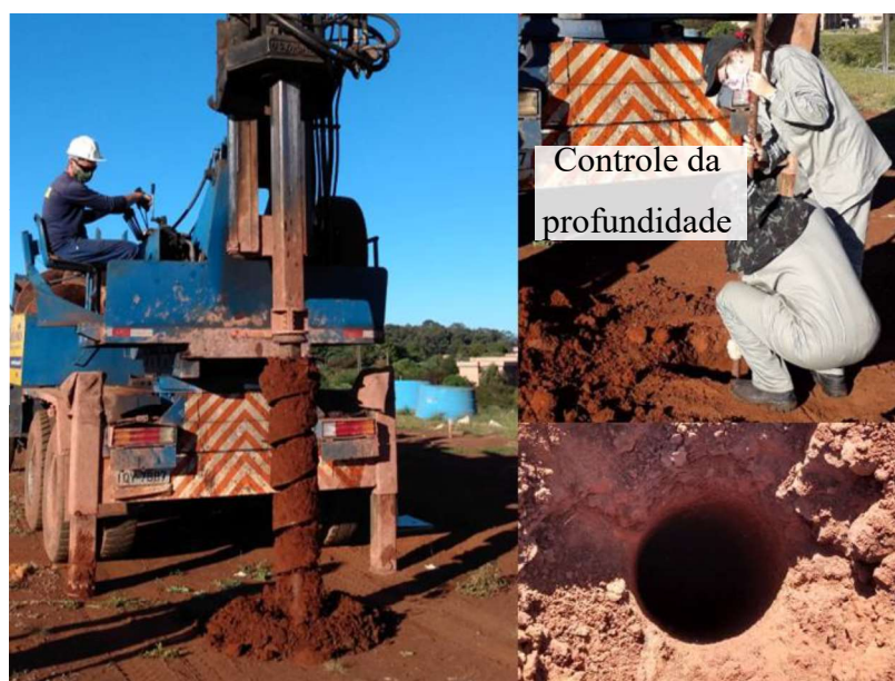
Figura 3.9: Escavação das estacas de 30 cm
