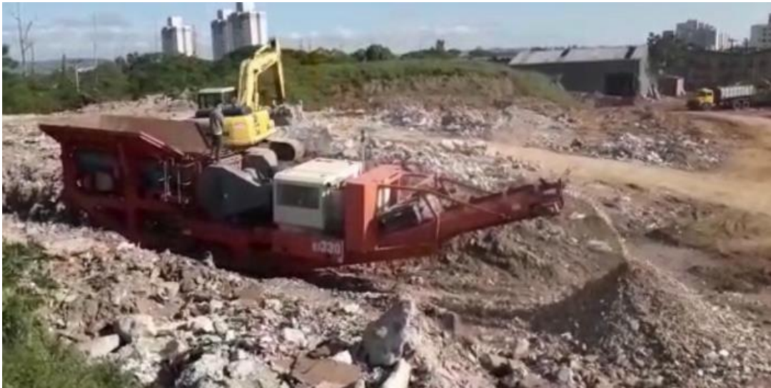
Figura 7 - Britagem do RCD no aterro
