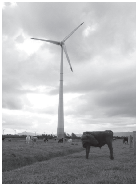
Figura 2. Fotografia de um dos aerogeradores do parque cercado de rebanho bovino.
