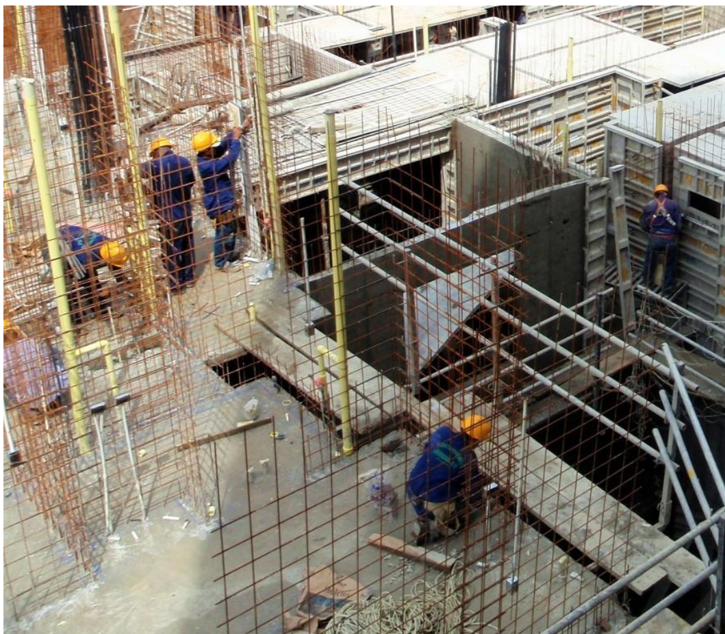
Figura 11 - Posicionamento das malhas de aço de paredes
