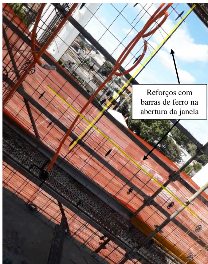
Figura 12 - Reforços com barras de ferro na abertura da janela
