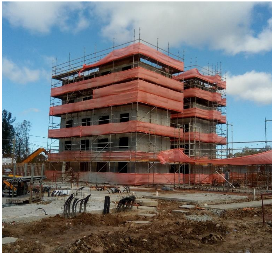
Figura 2 - Etapa de finalização do elemento estrutural
