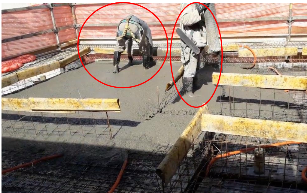
Figura 18 - Trabalhadores realizando a concretagem
