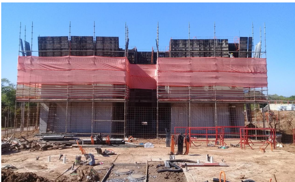
Figura 1 - Obra com paredes de concreto moldadas no local
