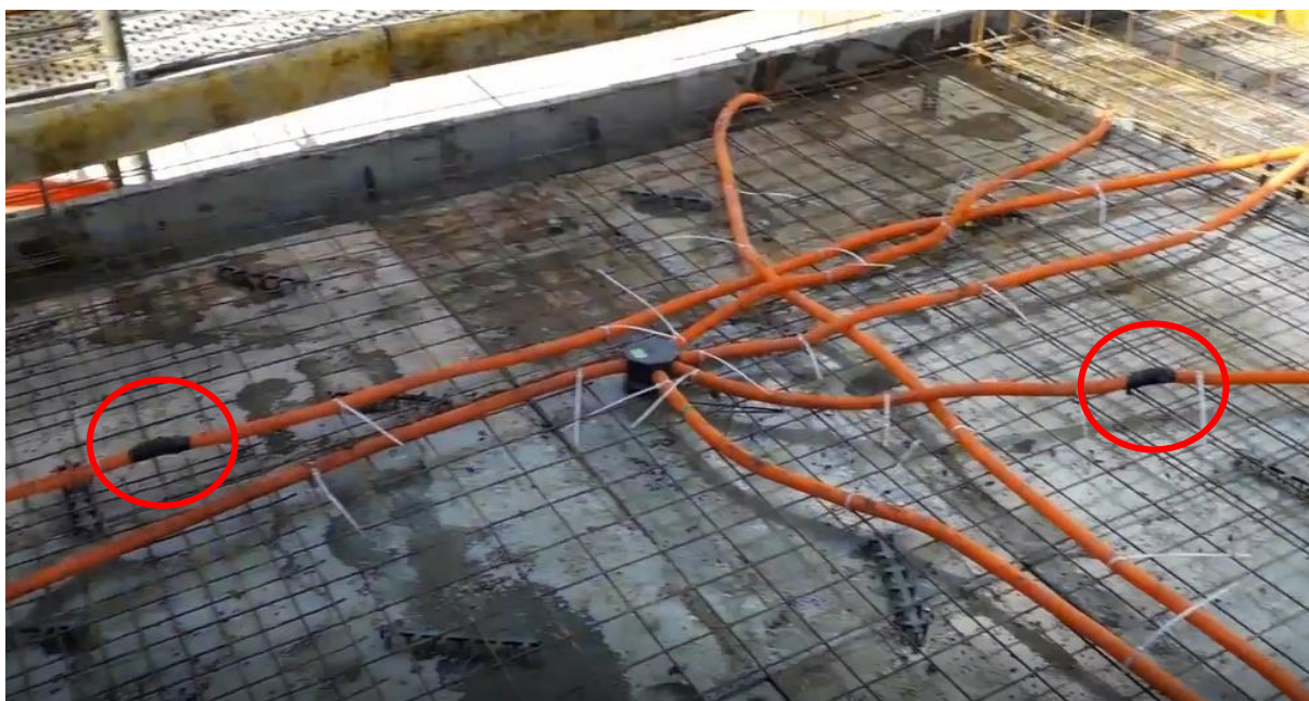
Figura 22 - Detalhe da fixação e reparo dos eletrodutos na laje
