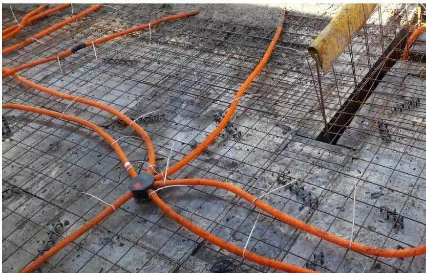
Figura 17 - Fixação dos eletrodutos nas malhas de aço da laje
