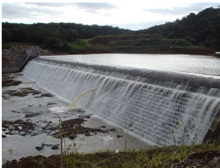
Figura 6 – Vertedouro tipo soleira livre.
