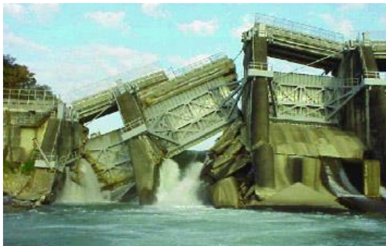
Figura 26 –Ruptura de barragem por causa de terremoto.
