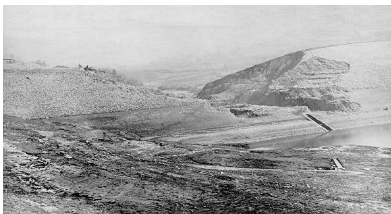
Figura 16 – Acidente na barragem Dale Dyke, Inglaterra.
