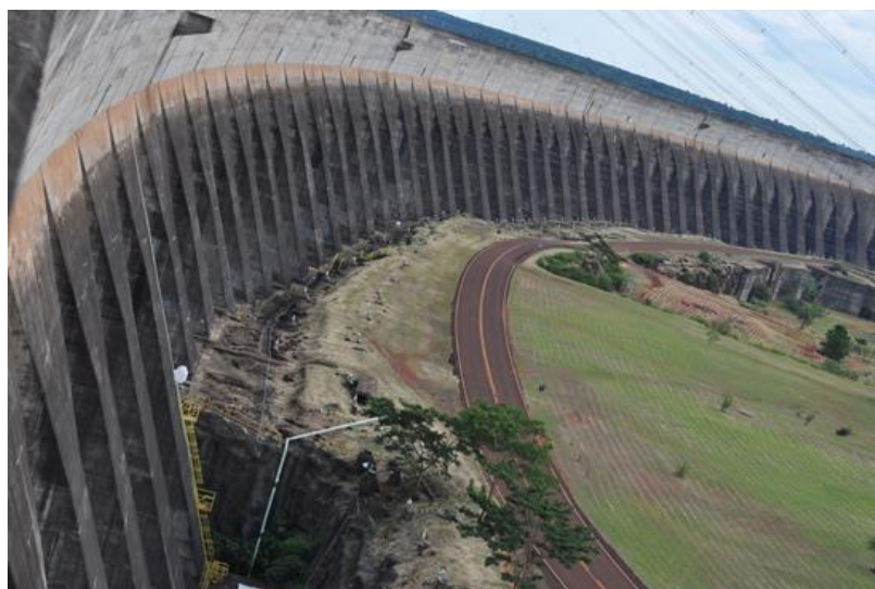
Figura 12 – Barragem de concreto em contrafortes.
