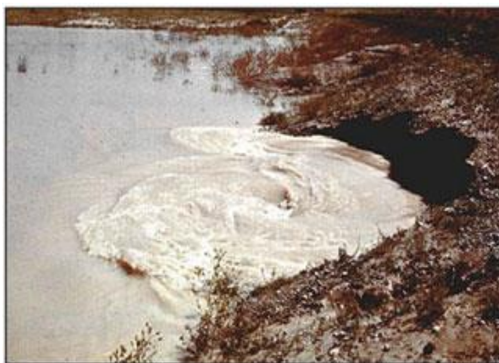
Figura 23 – Exemplo de erosão interna, “ piping ”.
