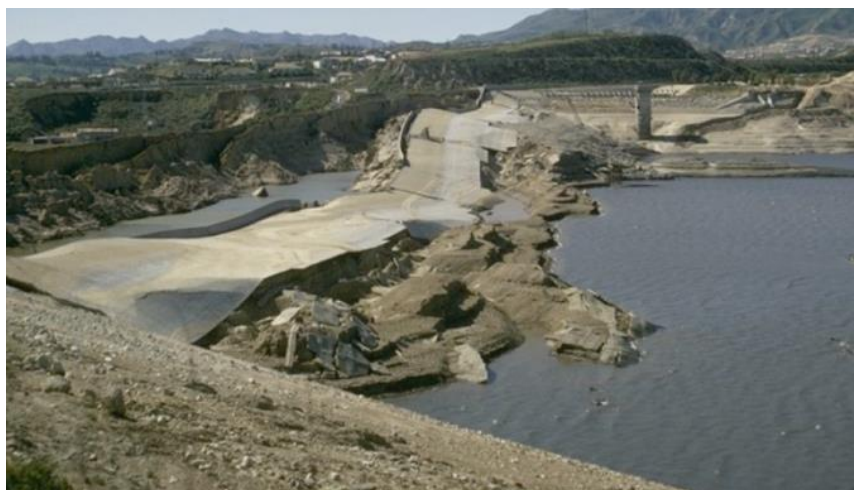
Figura 25 – Defeitos na fundação.
