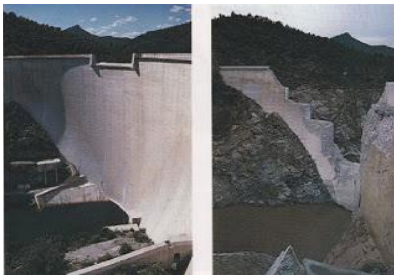
Figura 17 – Acidente na barragem Malpasset, França.
