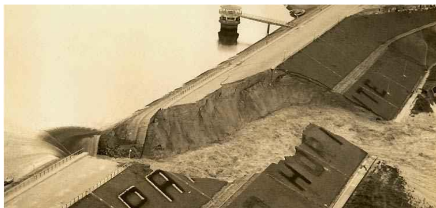
Figura 18 – Acidente na barragem Pampulha, Brasil.
