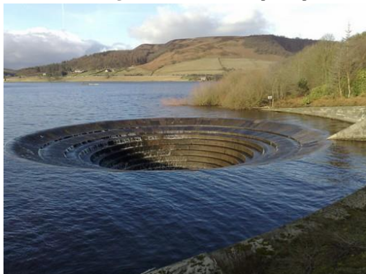
Figura 5 – Vertedouro tipo tulipa.
