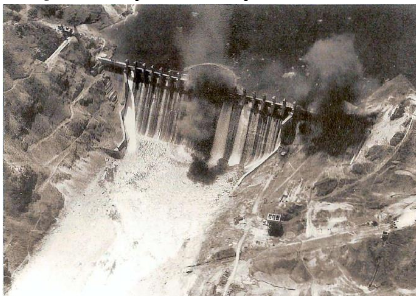
Figura 27 –Ataque aéreo à barragem Hwach'on,Coreia.
