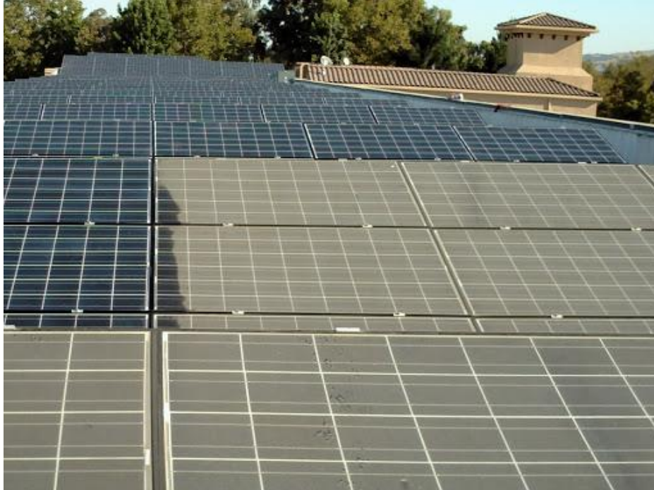
Figura 22 – Comparação entre painéis, com e sem acúmulo de poeira
