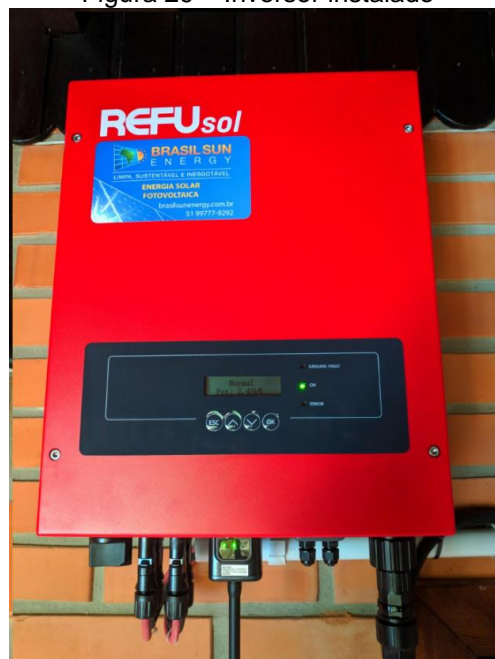
Figura 29 – Inversor instalado
