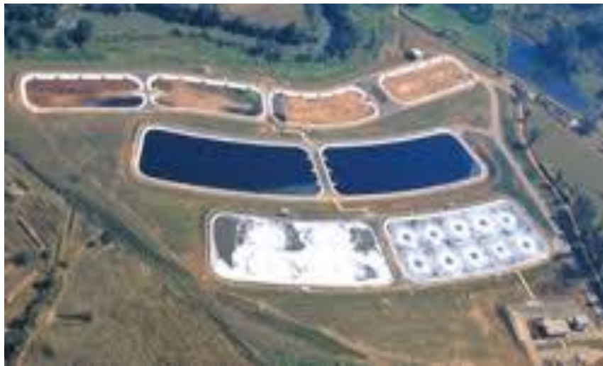
Figura 3.6. Lagoas aeradas seguidas de lagoas de decantação. Fonte: SABESP [15]
