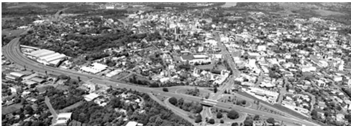
Figura 04: Vista aérea do entroncamento rodoviário (BR386-ERS 130) no perímetro urbano de Lajeado/RS.
