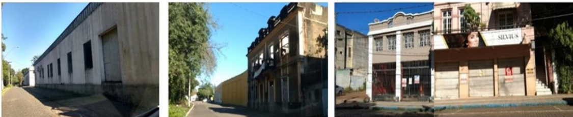
Figura 19: Área apresenta obsolescência, com grande número de imóveis desocupados e degradados
