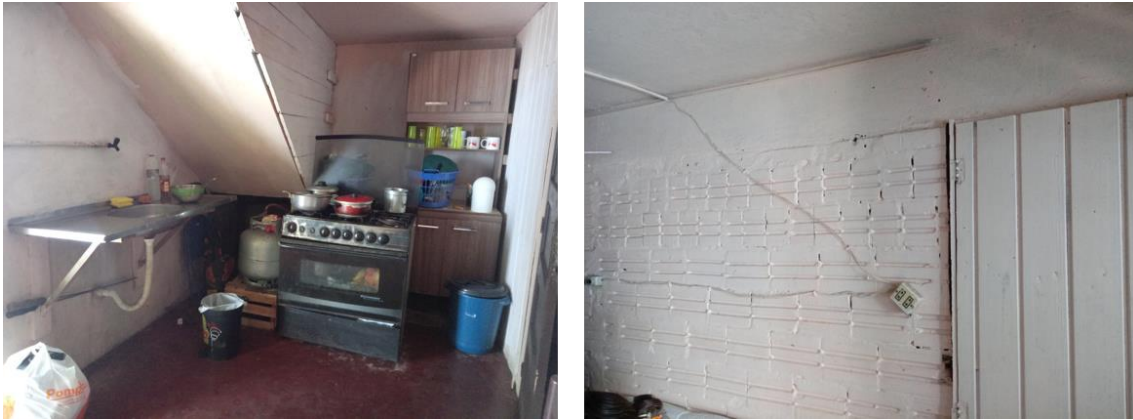
Figura 38: Vista parcial do interior de um dos cômodos de uma pensão alugada por haitianos. Cozinha junto de uma sala. Instalações elétricas, hidro e gás. Pouca ventilação e iluminação. Fonte: Da autora (2019).
