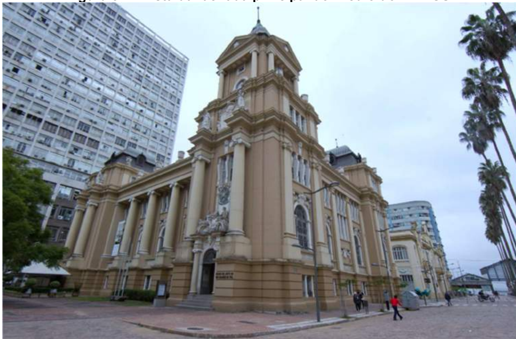
Figura 54 – Vista da fachada principal do Prédio do MARGS.
