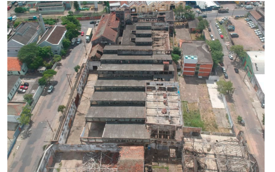
VISTA AÉREA GALPÕES. Fonte: Levantamento com drone
