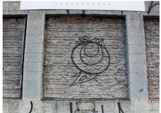
intervenção posterior: preenchimento de alvenaria leve
