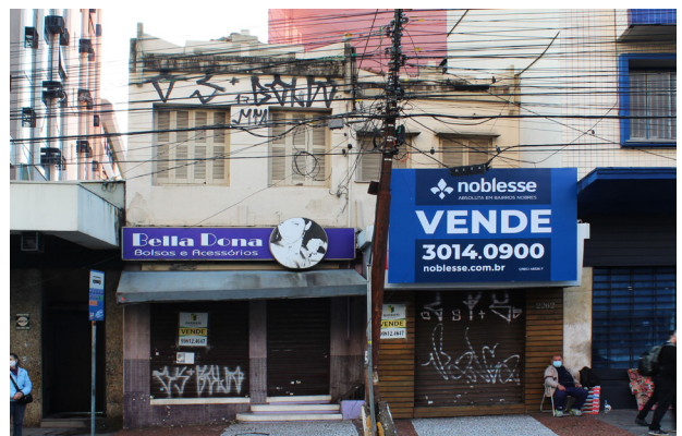
edificação a ser demolida na av. Cristovão Colombo
