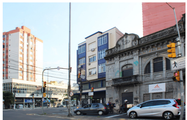
entorno cruzamento entre avenidas
