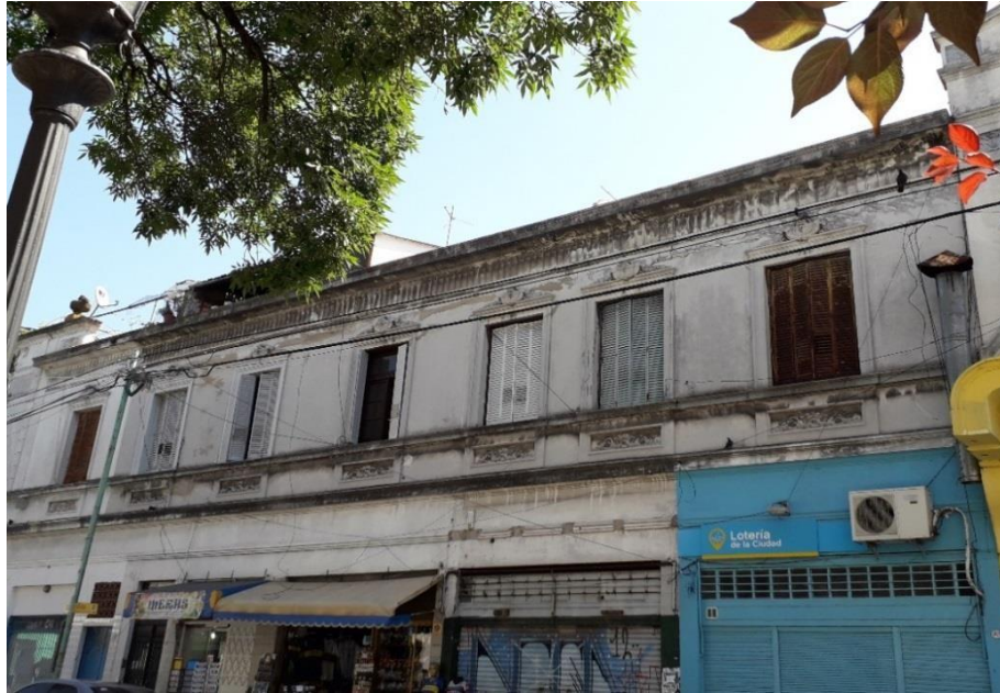
IMAGEM 026 – Sobrados no bairro de La Boca. Acervo Pessoal
