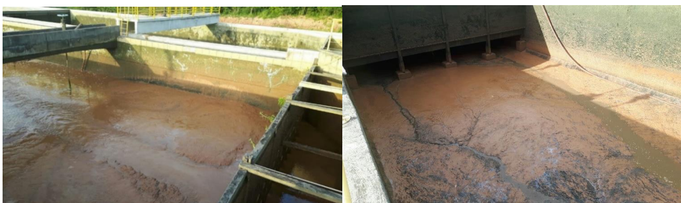
Figura 6: Decantadores da SEMAE em São Leopoldo/RS após os desastres de Rolante/RS (fonte: SEMAE).
