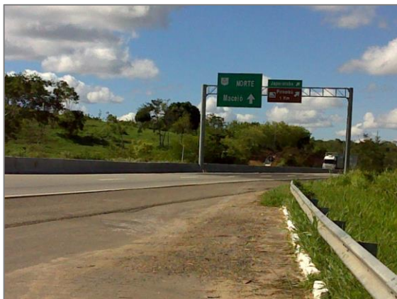
Figura 10 - Sinalização de indicação em pórtico, Japaratuba, 19/02/2020 Fonte: arquivo pessoal
