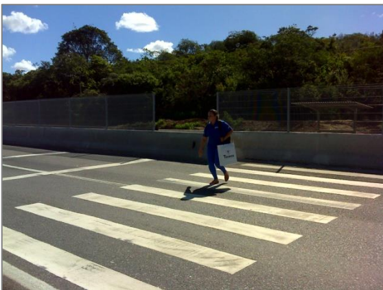
Figura 18 - Travessia de pedestre em abertura da barreira New Jersey, Japaratuba, 19/02/2020 Fonte: arquivo pessoal
