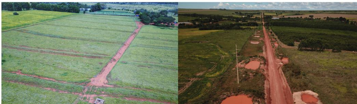
Figura 1 - Área terraceada (esquerda) e estrada com barraginhas (direita) no N.R Pipiripau
