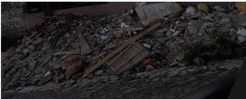
Figura 3: RCD - presença de tijolo, madeira, galão de tinta, papelão, plástico, lonas, entre outros
