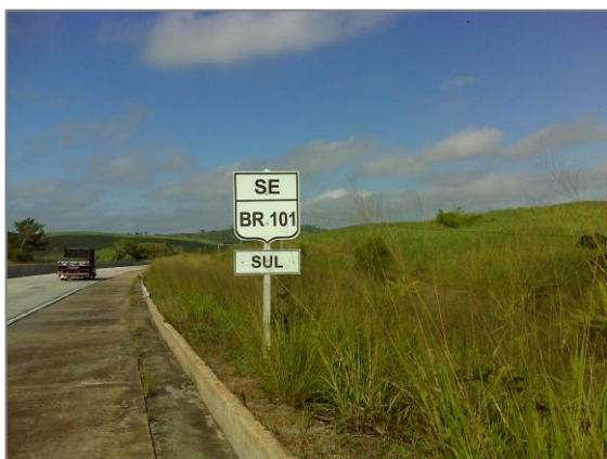
Figura 14 - Sinal de identificação de rodovia, Japaratuba, 19/02/2020 Fonte: arquivo pessoal
