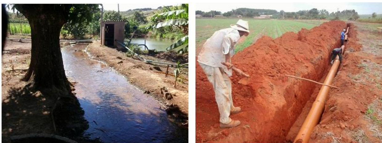
Figura 3 - Revitalização de canais de irrigação por tubulação total
