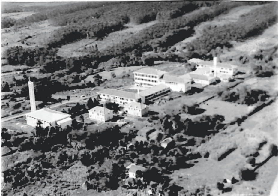
Figura 17 – Prédio da Escola Normal Evangélica (ENE)
